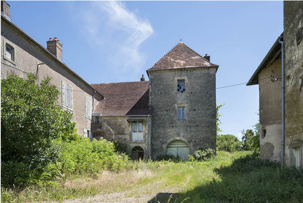
La cour intérieure de la maison forte.
