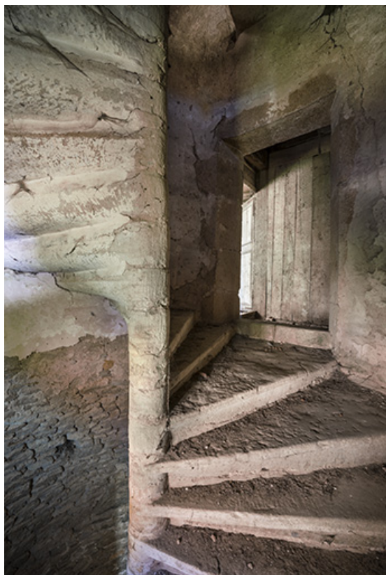
Escalier à vis, premier étage du logis 16e siècle. 70, Ferrières-lès-Scey
