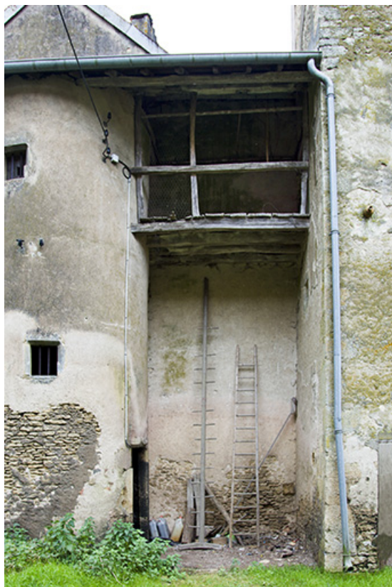
La galerie couverte reliant la tour circulaire abritant les escaliers et le colombier. 70, Ferrières-lès-Scey
