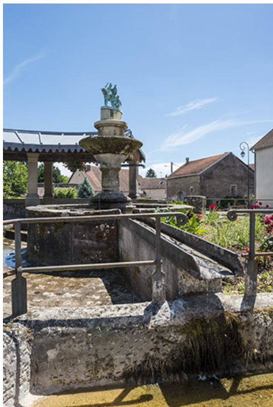
Détail de la fontaine.
