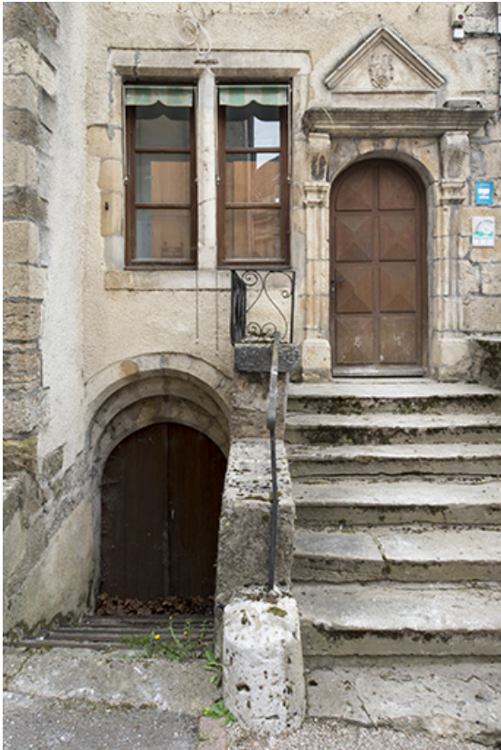
Les ouvertures permettant d'accéder à la maison et à la cave.
