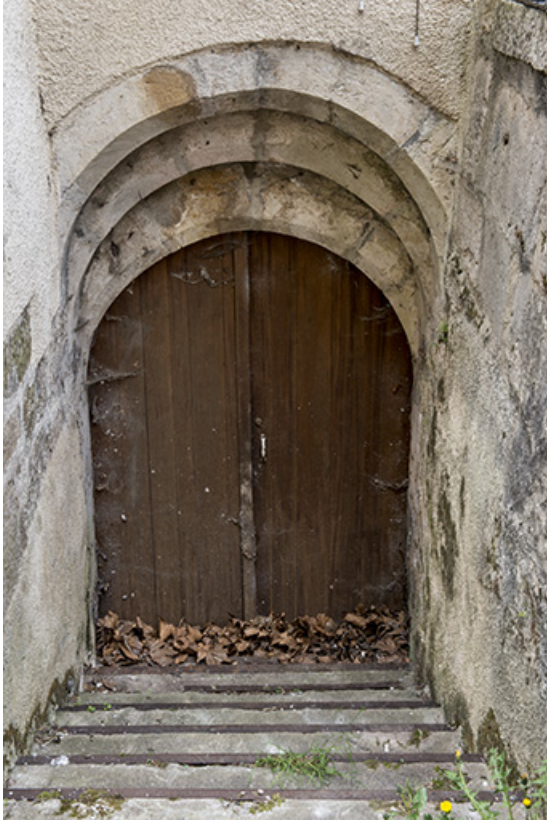
L'accès à la cave par une porte disposant d'une succession d'arcs chanfreinés. 70, Port-sur-Saône rue Jean Bogé
