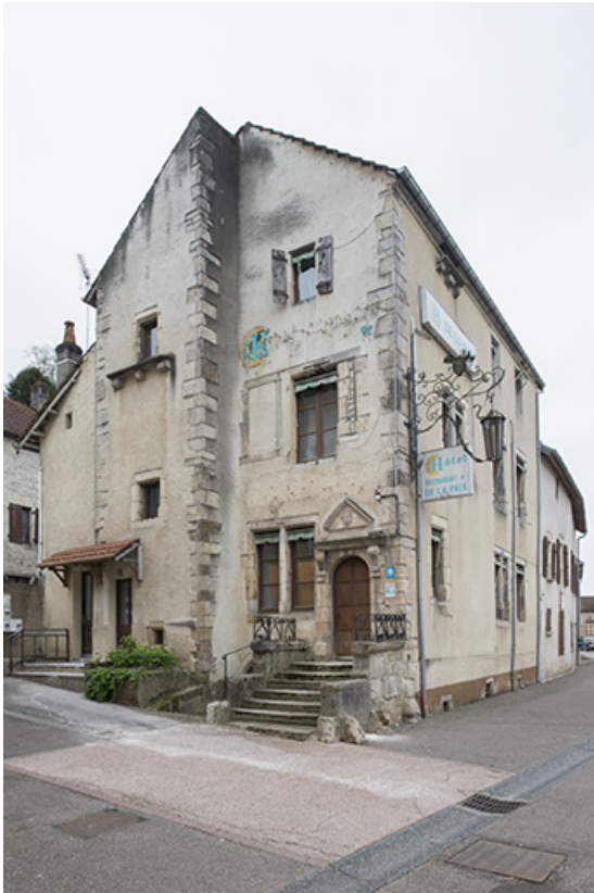
Vue générale depuis la rue Jean Bogé.
