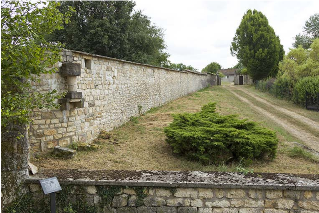
Le mur d'enclos du couvent.
