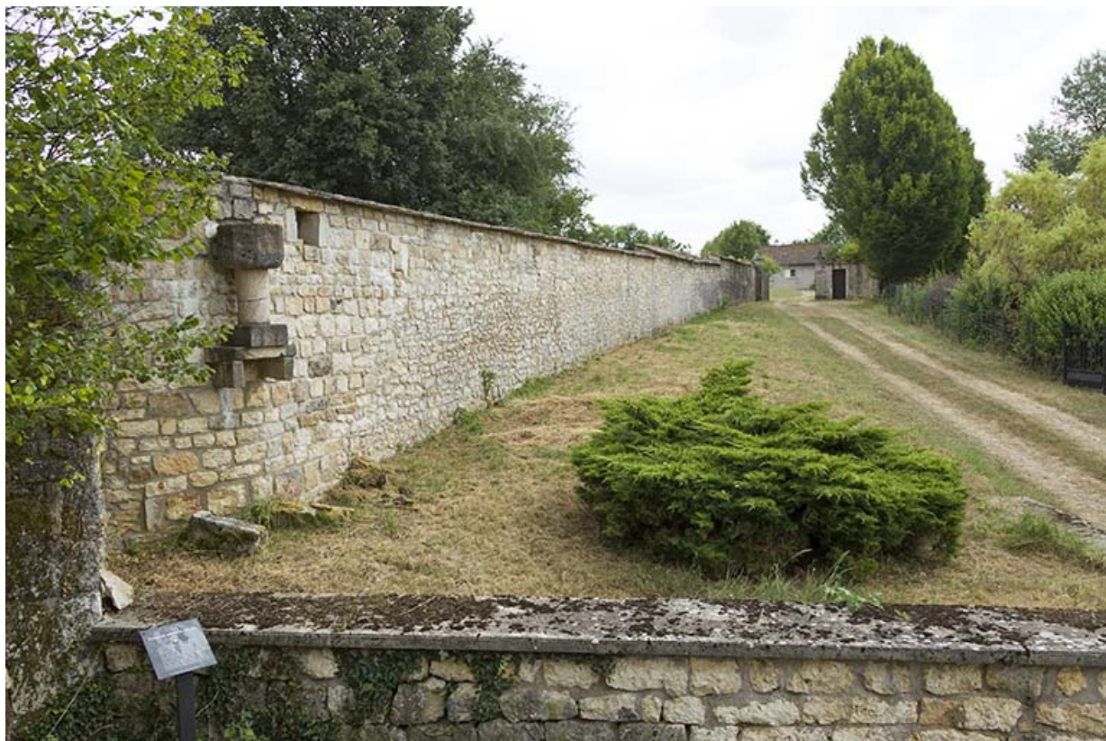
Le mur d'enclos du couvent.
