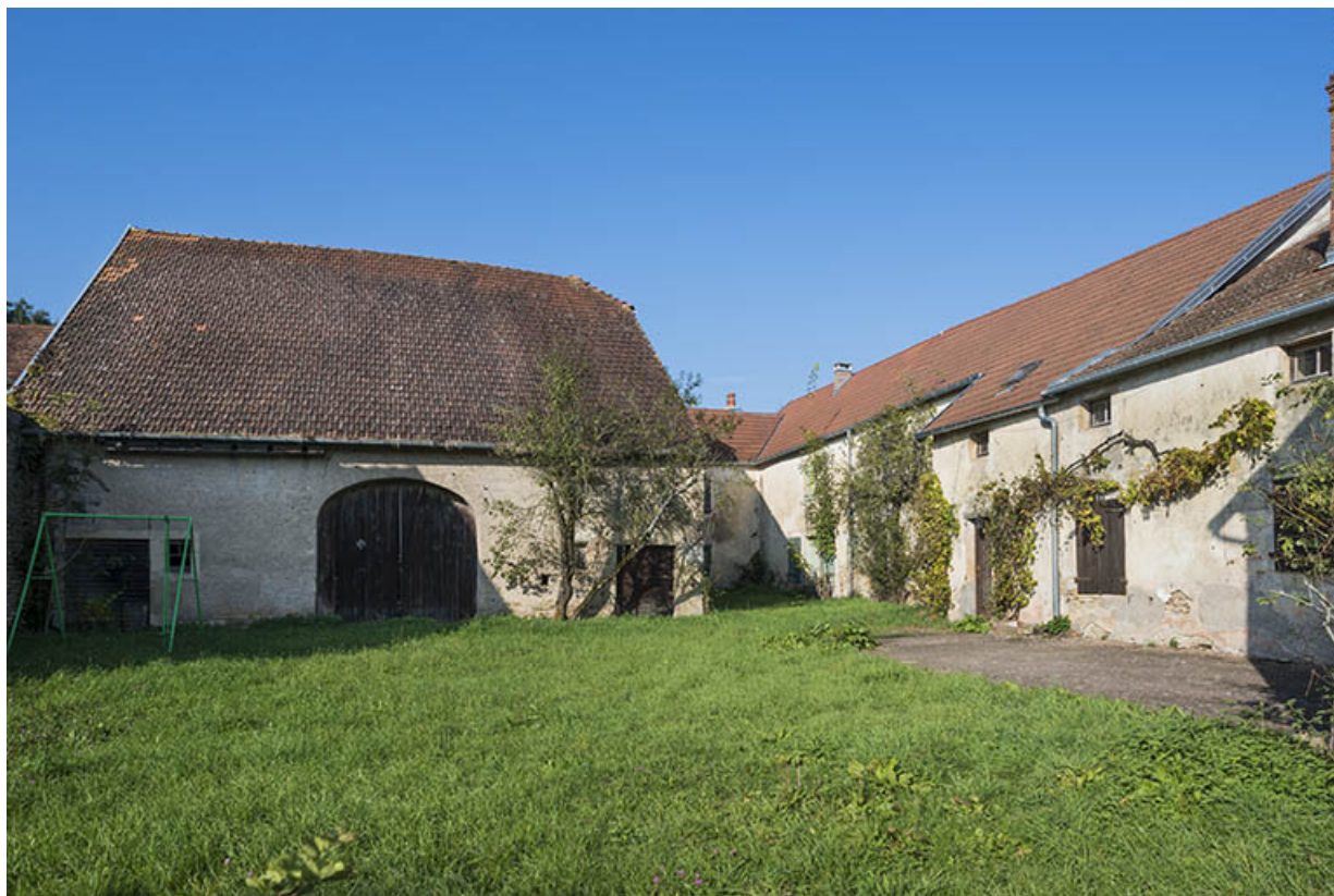
Vue générale de la cour et des bâtiments composant la ferme actuelle.
