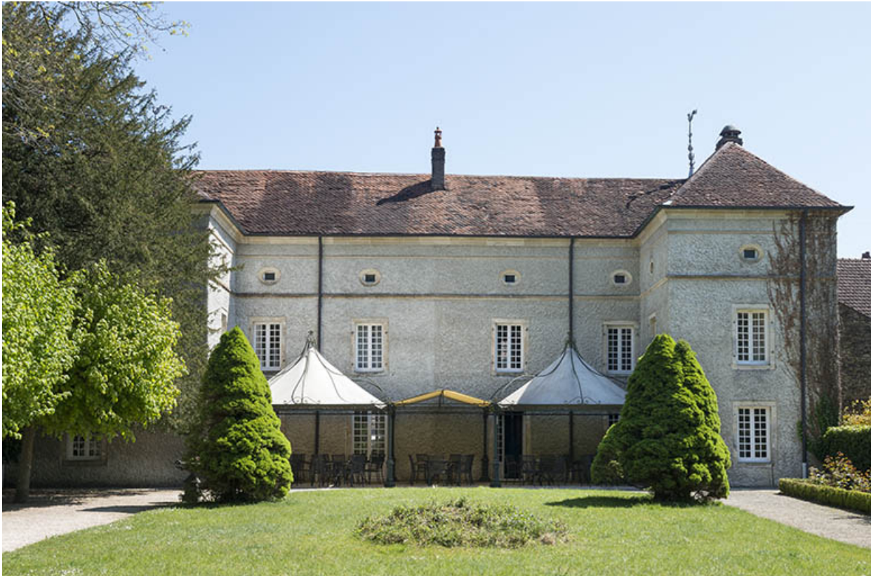
La façade postérieure.
