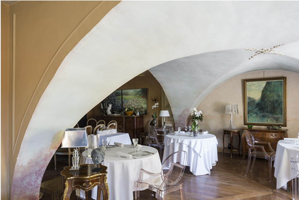
Détail d'une des voûtes.
