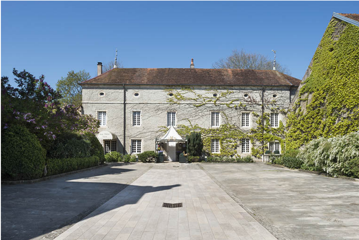
La cour et vue sur la façade principale.
