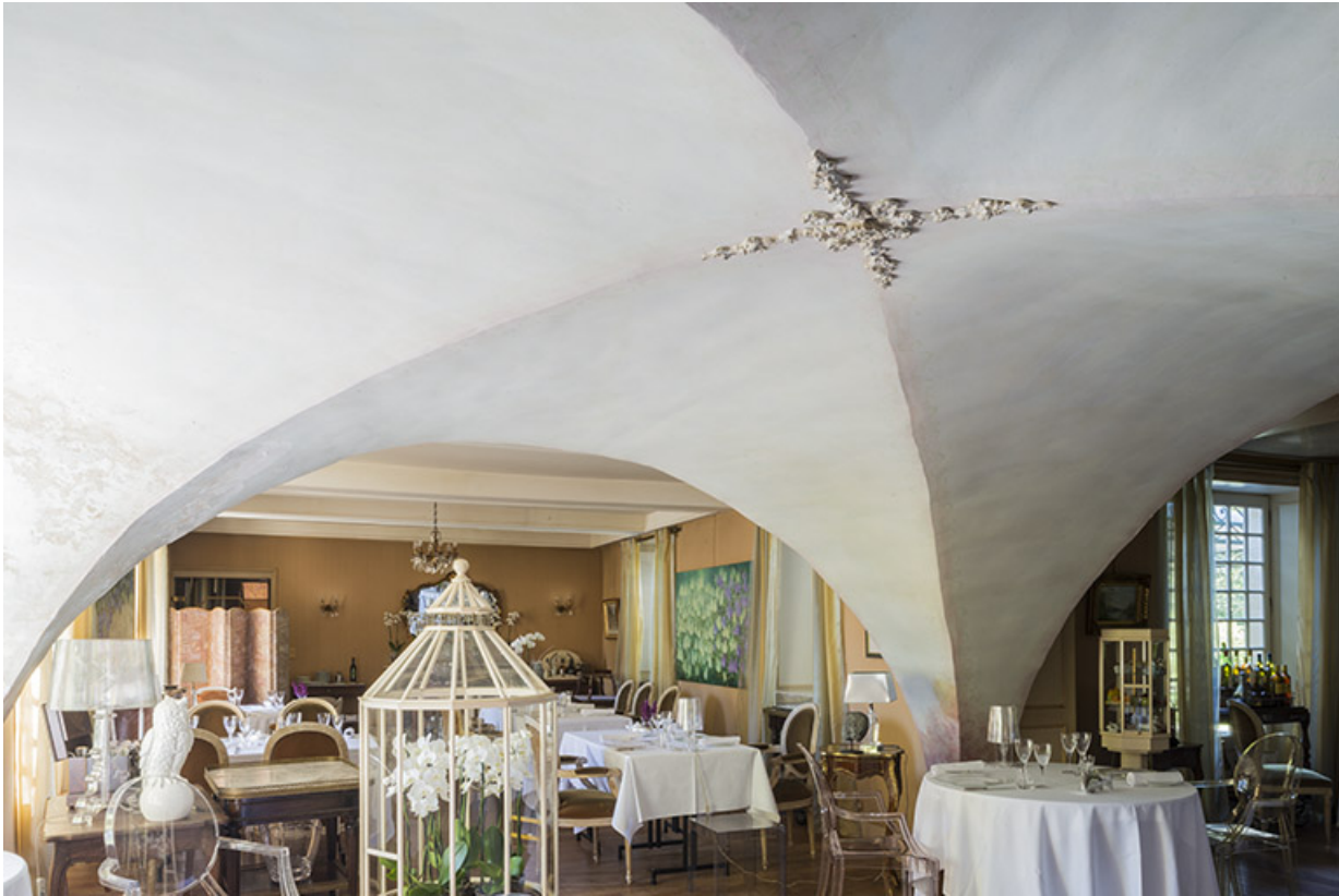
Vue depuis l'extrémité Nord.
