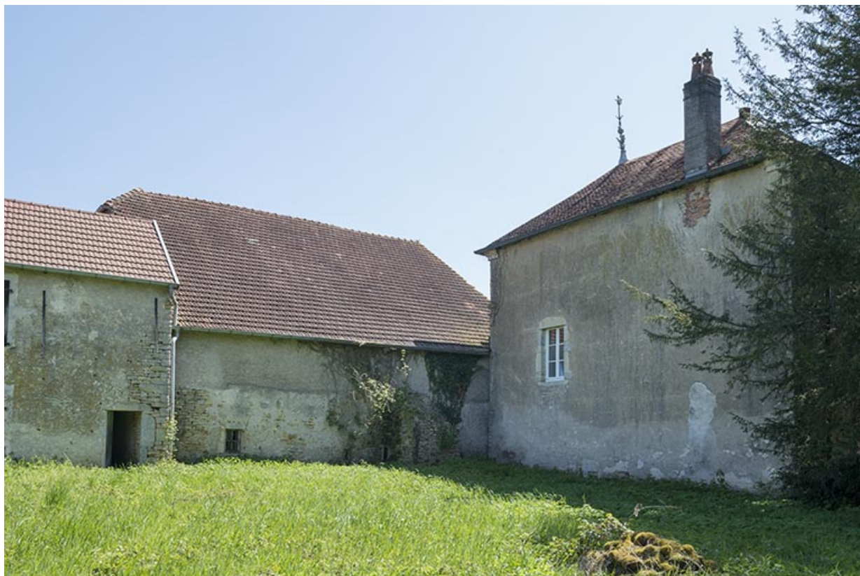
Le mur pignon du pavillon nord du château.
