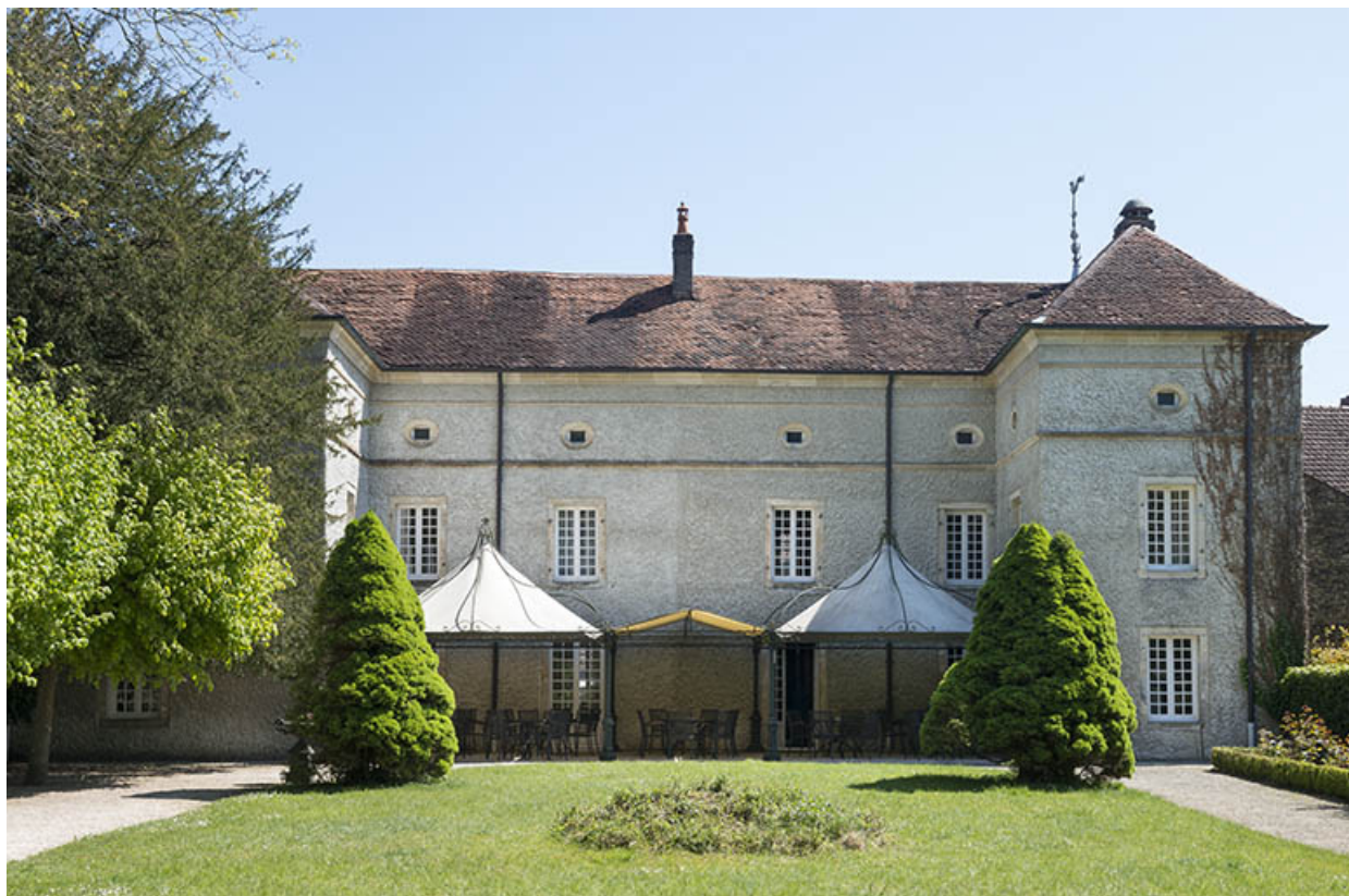
La façade postérieure.
