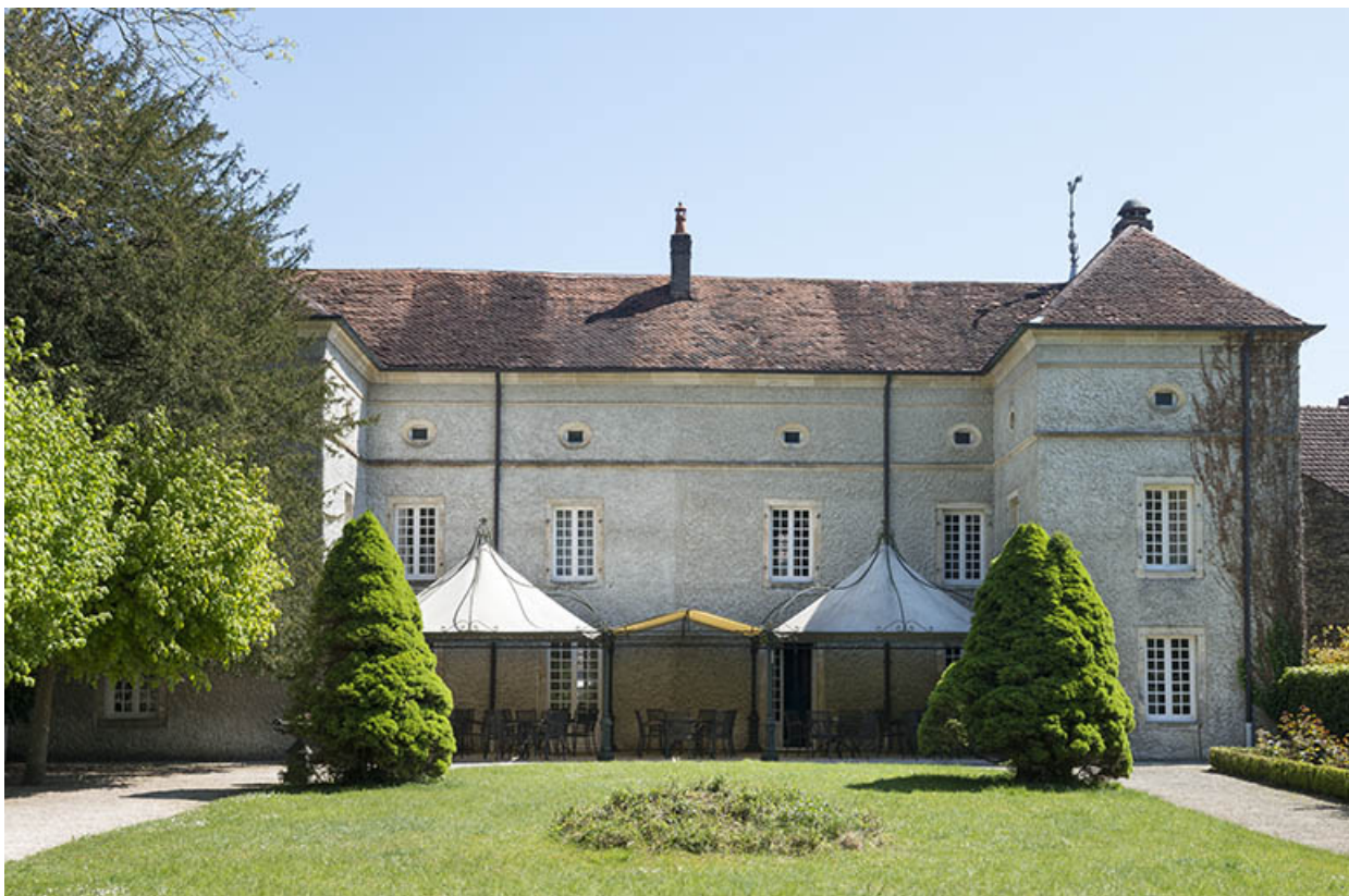
La façade postérieure.
