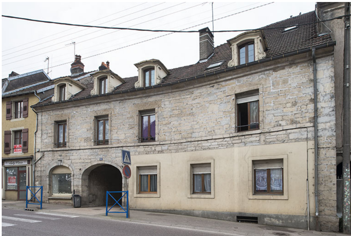
La façade principale depuis la rue.
