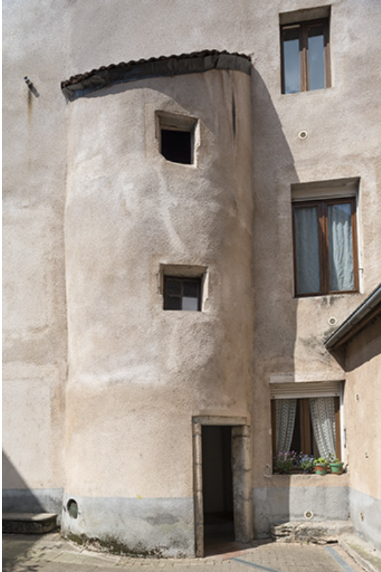
Tour comprenant un escalier, cour intérieure.
