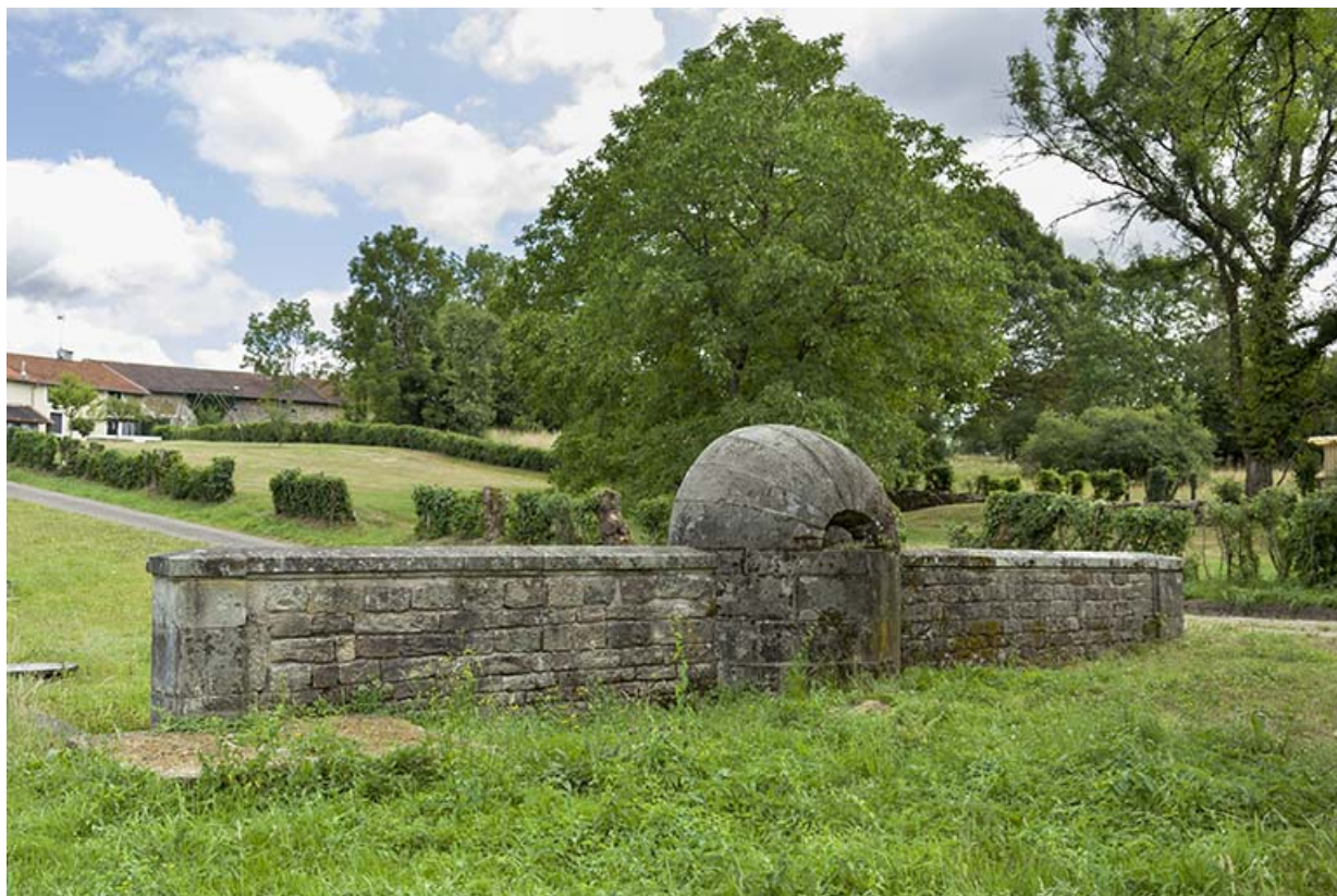
Fontaine des Carelles, chemin de la patouillette. Vue d'ensemble de la face postérieure.
