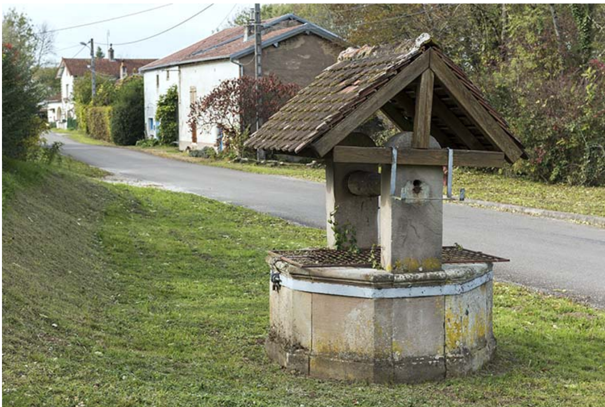
Puits, situé au carrefour avec la route de Seilles.
