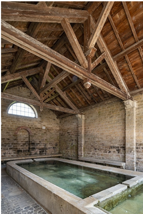
L'intérieur du lavoir, depuis l'entrée.
