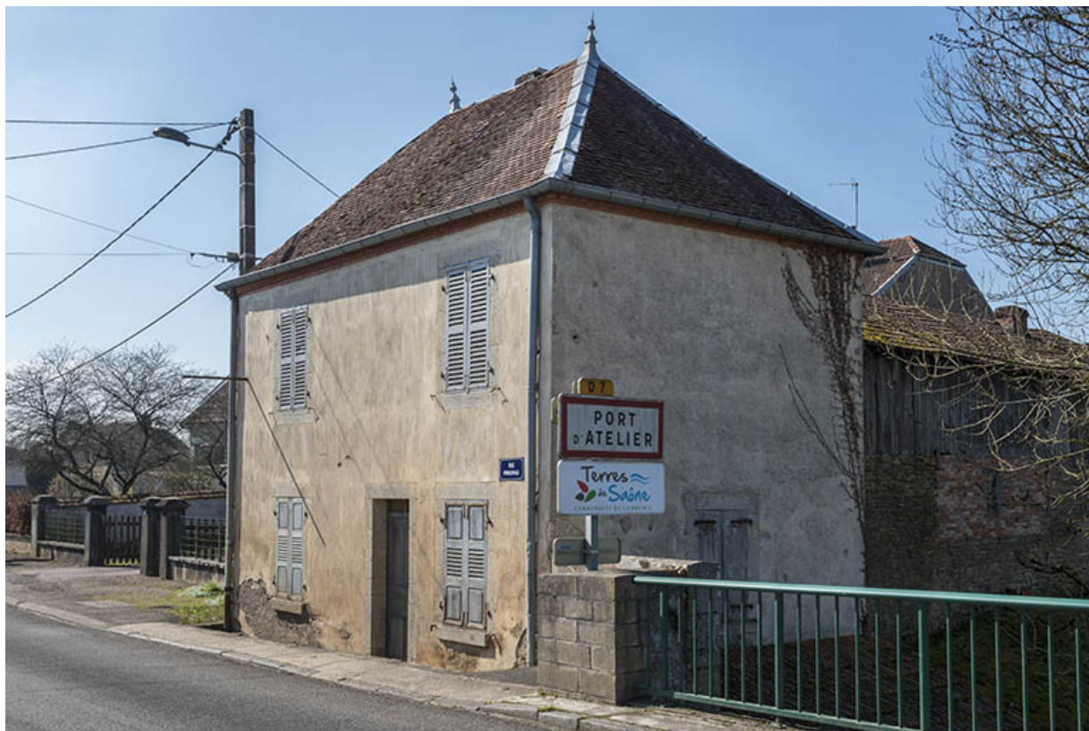
La maison du péagiste à Port-d'Atelier. 70, Purgerot
