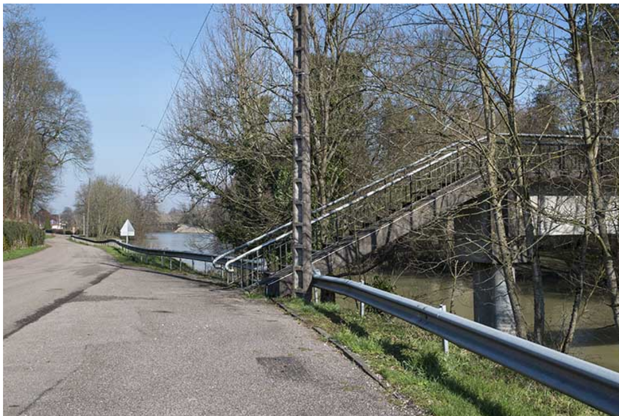
Passerelle enjambeant la Saône et reliant le village à l'usine. 70, Conflandey
