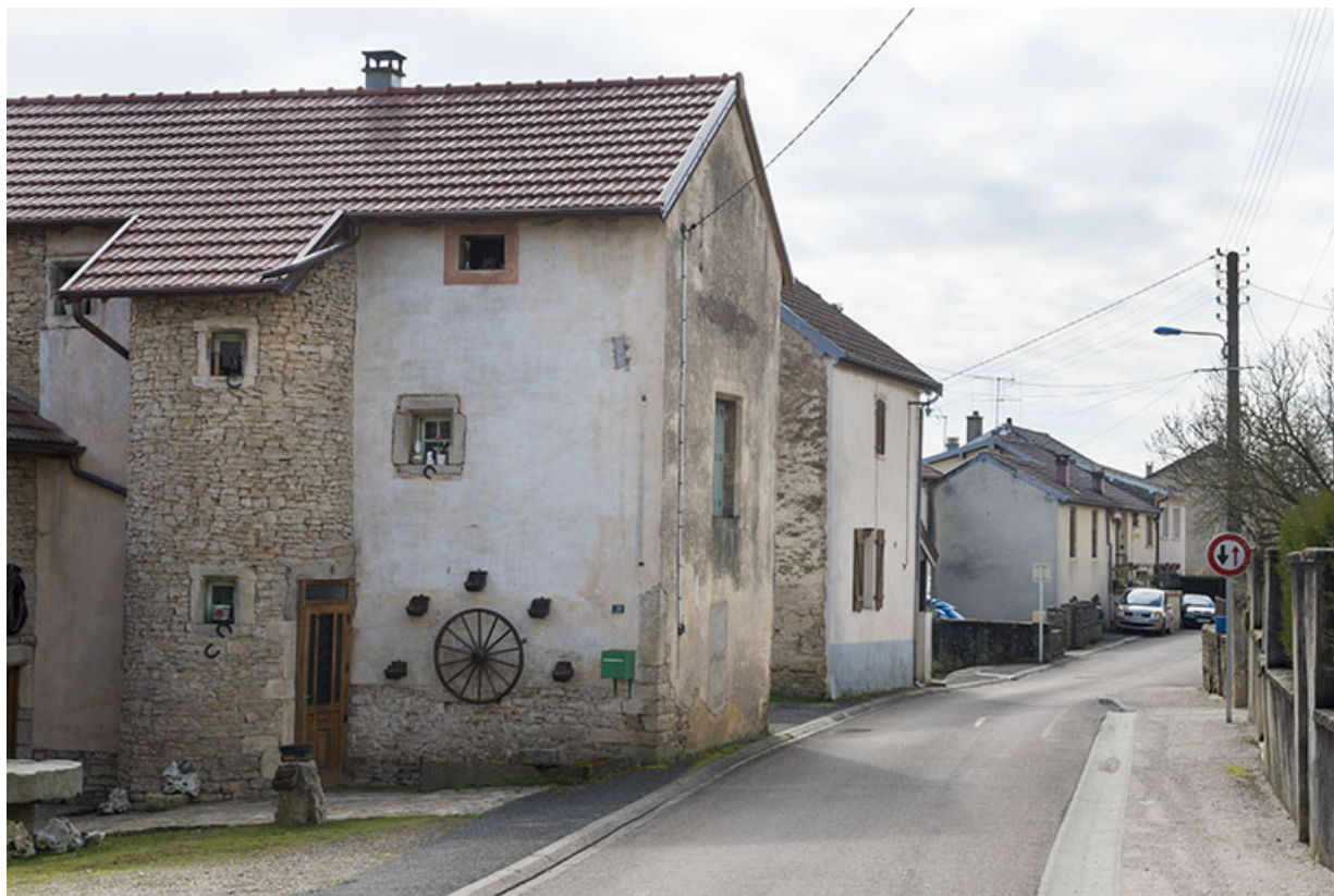
Ferme en équerre dotée d'une tour. 70, Conflandey
