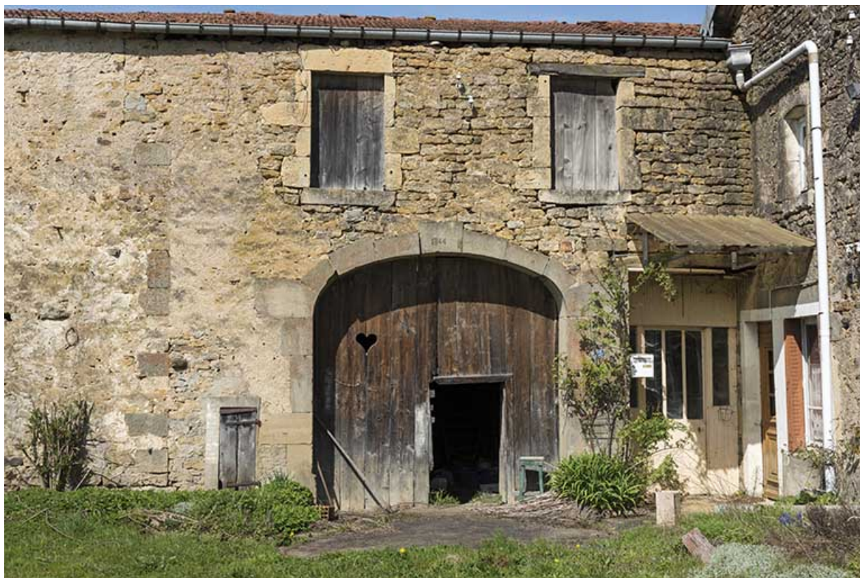
Détail d'une des deux portes de grange avec date portée : 1844. (25 route de Vittel. ) 70, Betaucourt
