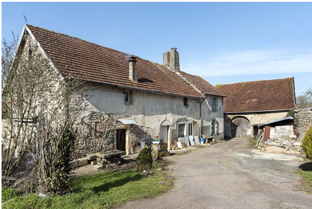
Ferme à l'ouest de l'ancienne cure (parcelles cadastrées D 562 et 446) : façade antérieure est. 70, Cendrecourt
