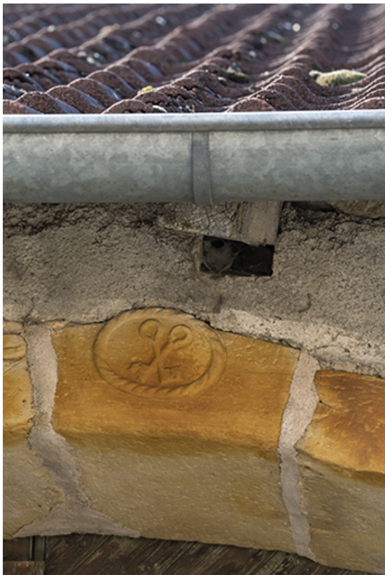
Détail de linteau portant un symbole à deux clés, sur la porte de grange ( 2 rue du Château) 70, Cendrecourt
