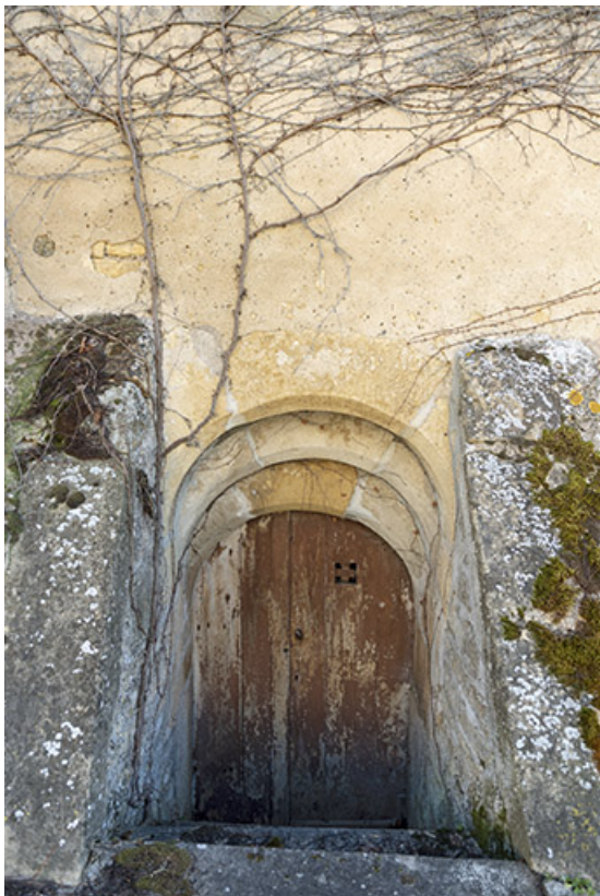
Entrée de cellier à arc en plein cintre, à ressauts formé de trois rouleaux. 70, Cendrecourt
