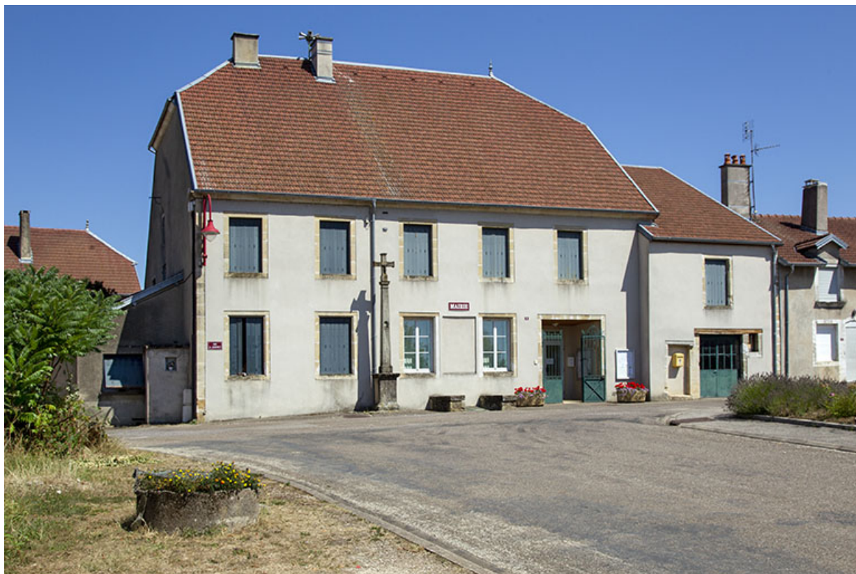
Vue de trois-quart de la façade antérieure de l'ancienne école, actuel hôtel de ville. 70, Cendrecourt
