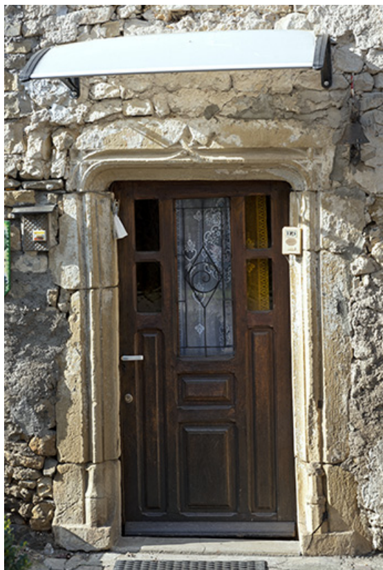
Ferme à l'ouest de l'ancienne cure (parcelles cadastrées D 562 et 446) : vue rapprochée de la porte à piédroits moulurés. (emploi?) 70, Cendrecourt
