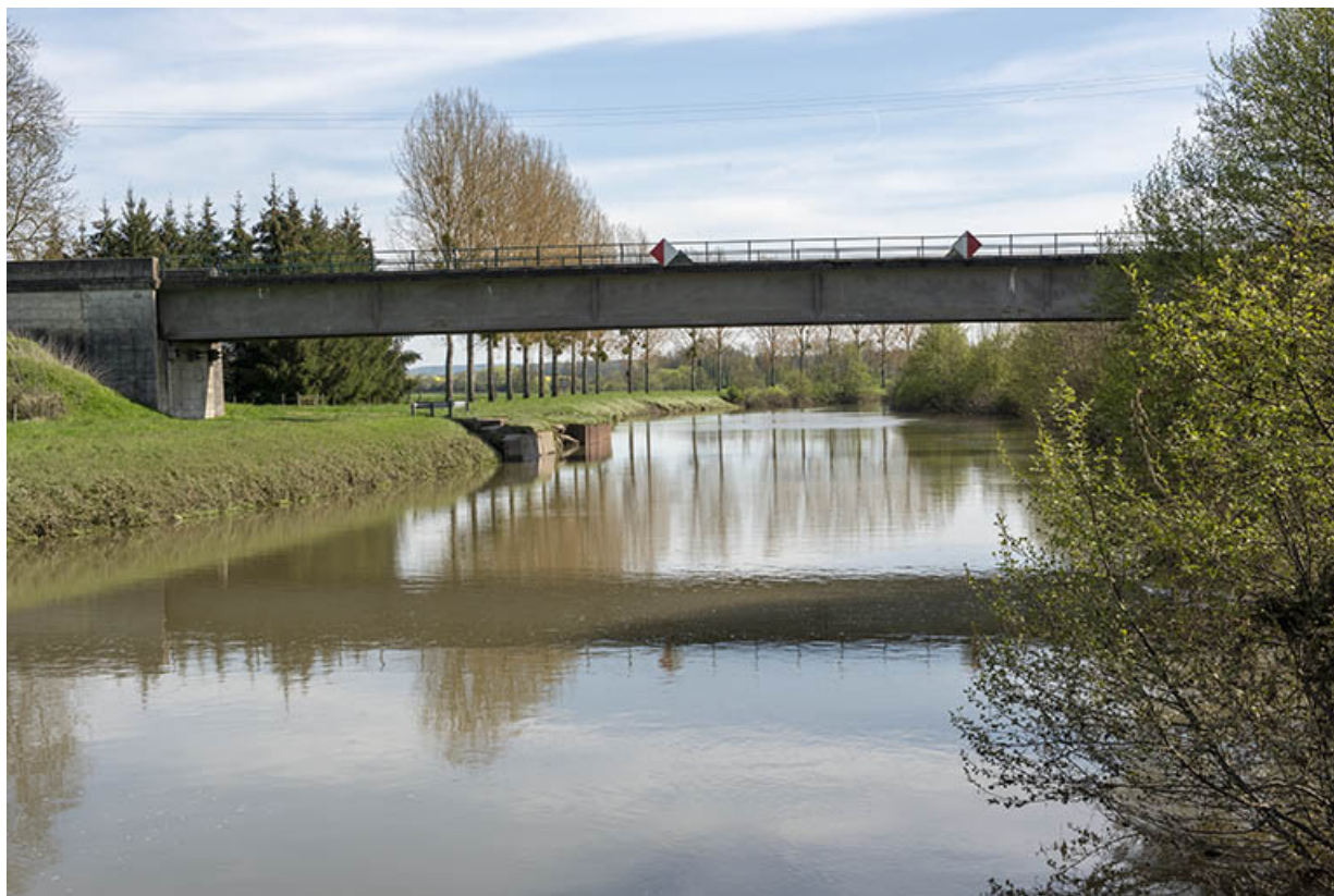
Vue sur le pont de la départementale 46 franchissant la Saône. Vue vers l'amont. 70, Cendrecourt
