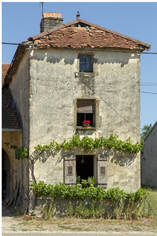
Détail du pignon de la ferme 17 rue du Jardiney. 70, Cendrecourt
