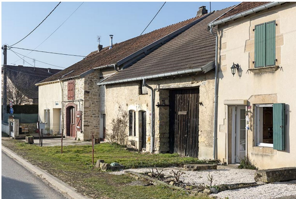
Alignement : 9 et 11 route de Vénisey. (Départementale 46.) 70, Cendrecourt
