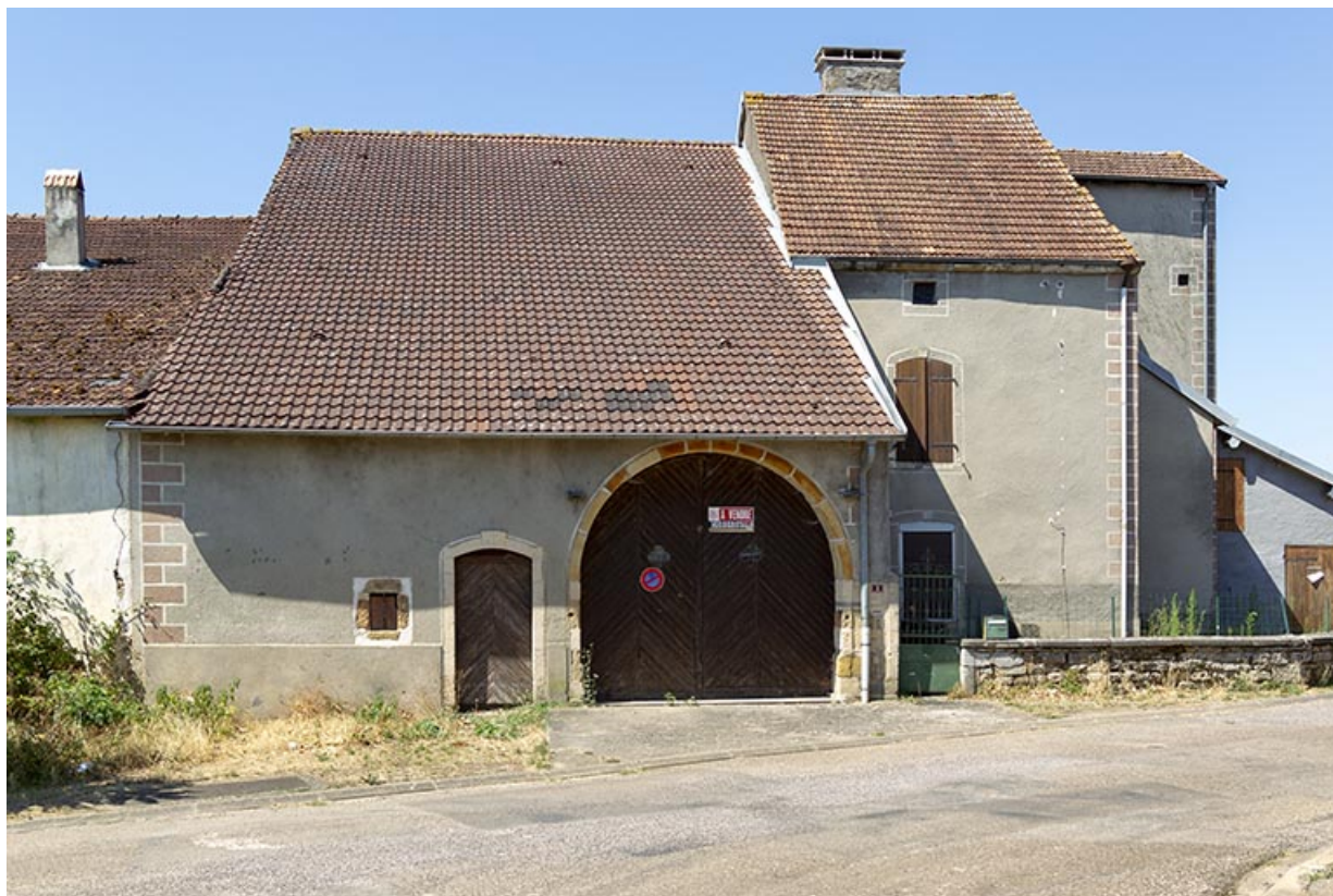
Façade antérieure, porte de grange et porte piétonnière, 2 rue du Château. 70, Cendrecourt
