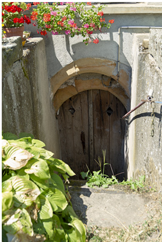
Entrée de cellier à arc en plein cintre, à ressauts formé de deux rouleaux. (4 rue du Château.) 70, Cendrecourt
