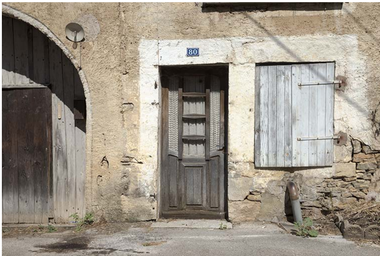
La porte donnant accès au logement de la ferme. 70, Purgerot
