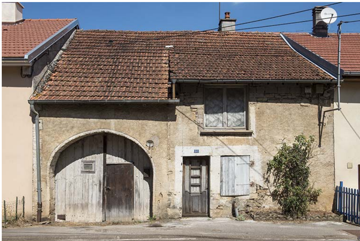
Ferme-bloc à deux travées.
