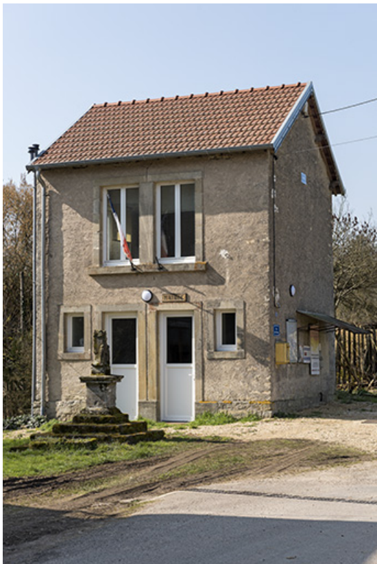
Vue de trois-quart nord-est de la mairie (ancienne distillerie, ancienne chambre à four) et calvaire. 70, Ranzevelle
