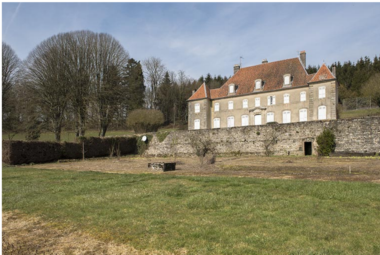
Façade antérieure (sud) du château.
