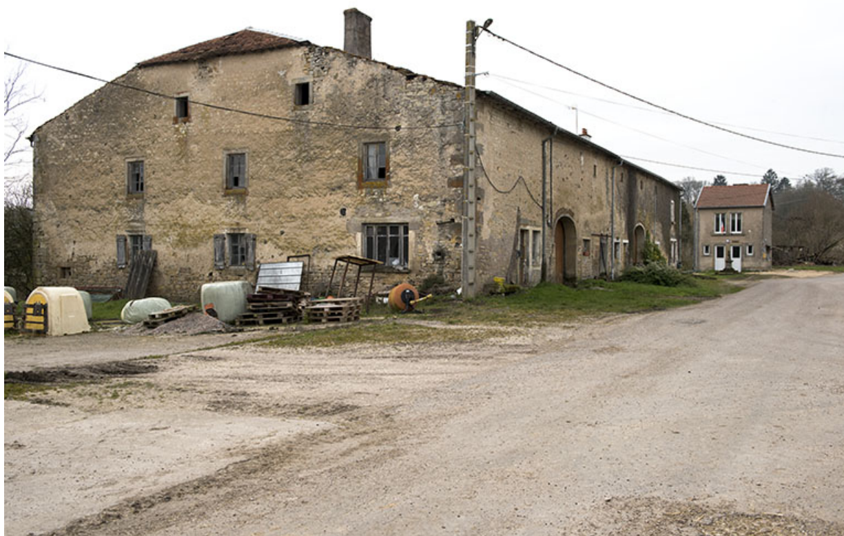
Vue de trois-quart nord-est de la ferme rue du château ; la mairie en second plan. 70, Ranzevelle
