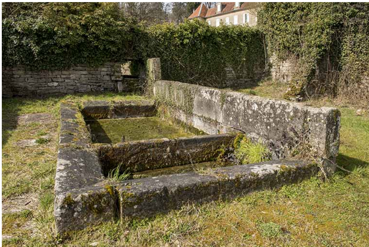
vue de l'est de l'ancien lavoir.
