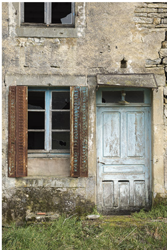
Détail de baies de la ferme située grande rue. 70, Ranzevelle
