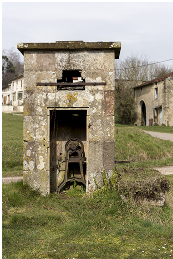
Vue de face (sud) de la fontaine.
