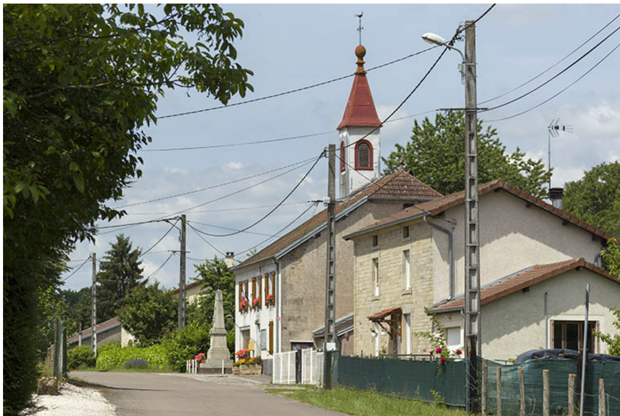
La mairie vue de trois-quart depuis l'est. 70, La Basse-Vaivre
