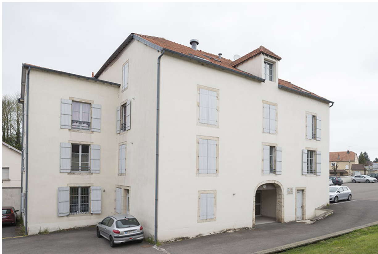
Façade postérieure, vue de trois-quart.
