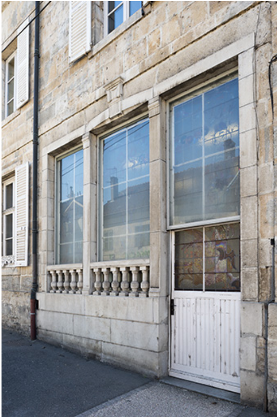
Partie occidentale de la façade antérieure. 70, Port-sur-Saône, 67 rue François Mitterrand
