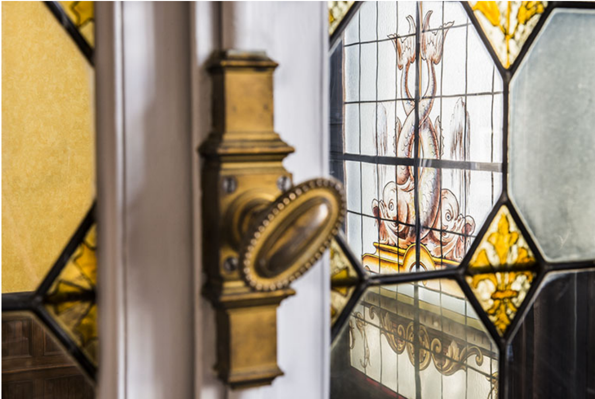
Aperçu de la verrière de la salle de bal par le châssis vitré à motifs géométriques.
