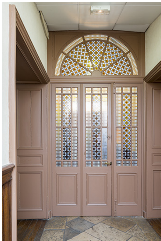
Porte intérieure vitrée du vestibule.
