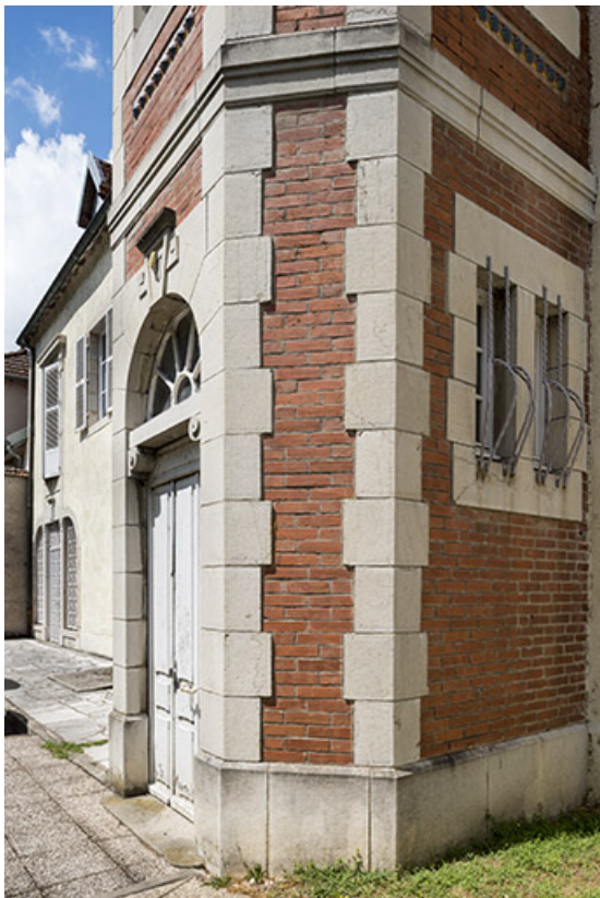
Base de la tourelle avec jeux de chaînages en pierre de taille.
