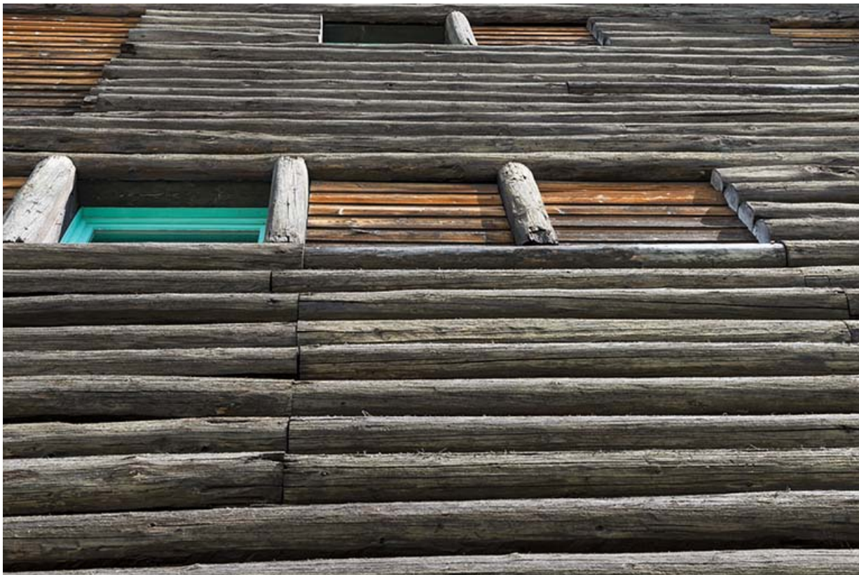
Le mur recouvert de demi-rondins de sapin.
