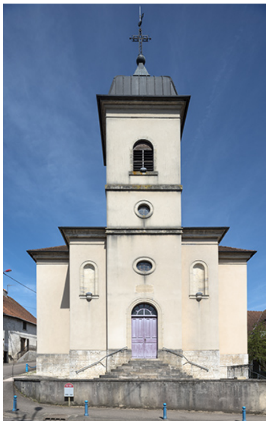
La façade antérieure de la chapelle.
