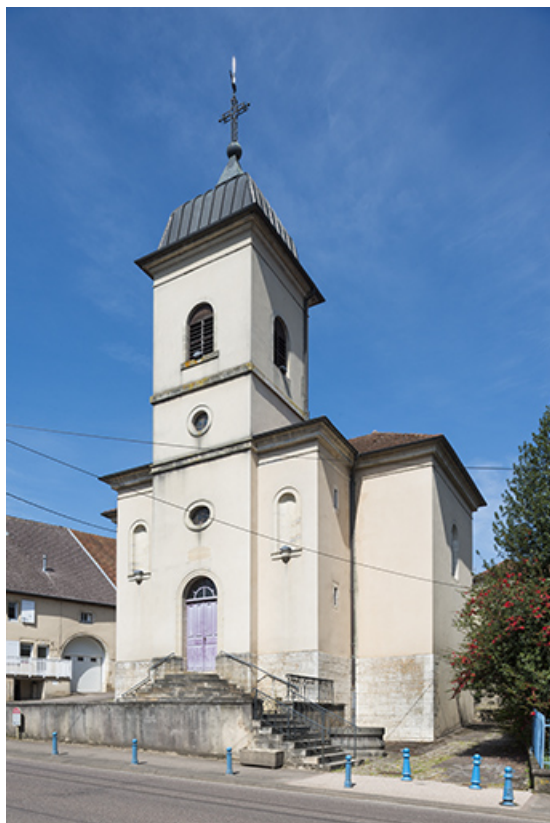
La chapelle, vue de trois-quart.
