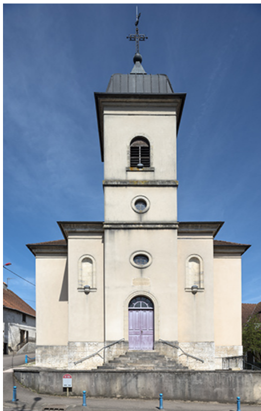
La façade antérieure de la chapelle.
