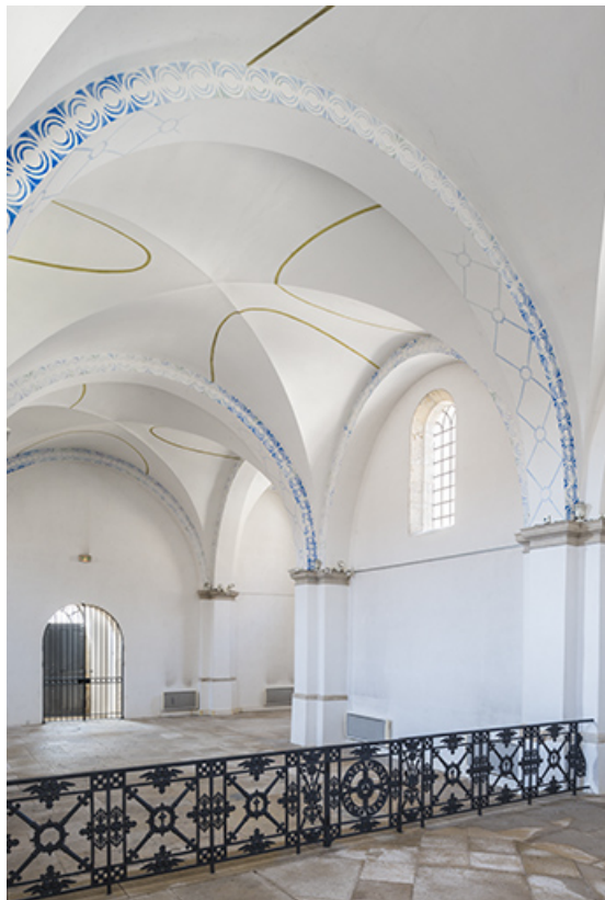
Vue du plafond en voûte.
