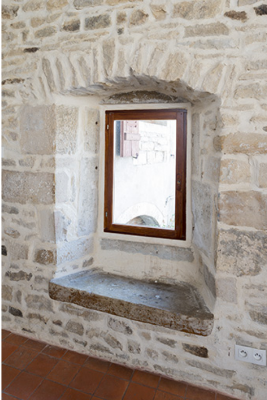
Fenêtre avec pierre à évier, premier étage.
