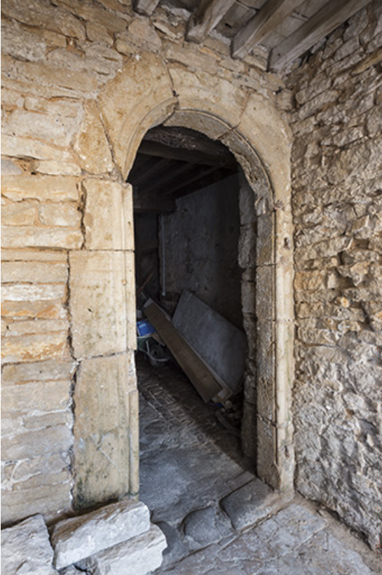
Porte d'accès à la grange, rez-de-chaussée. 70, Port-sur-Saône rue de l'Église
