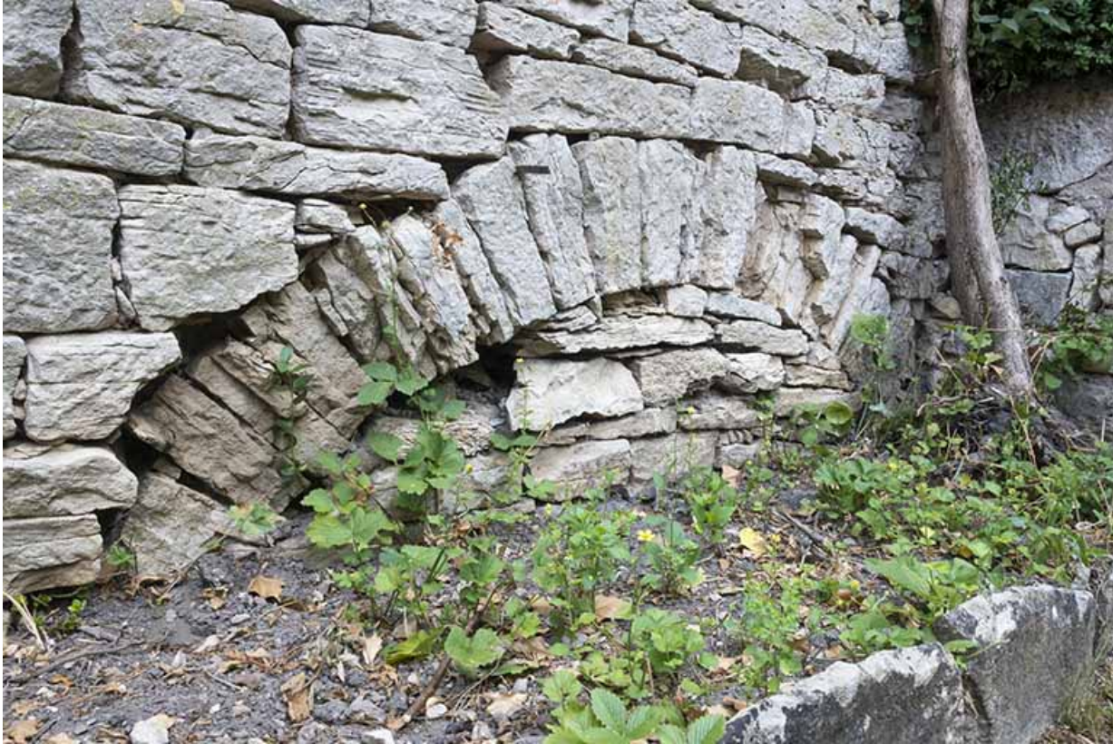
Détail sur la maçonnerie d'une voûte.
