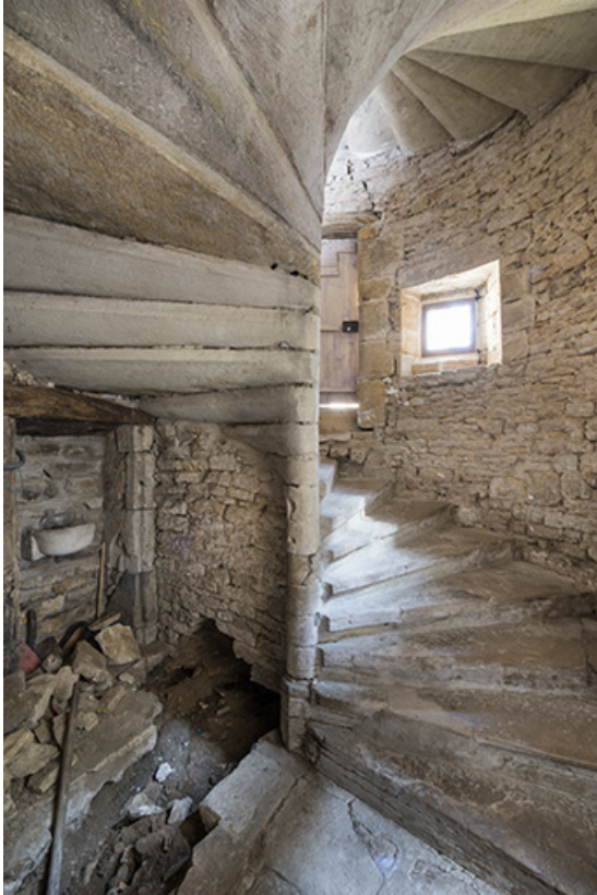
L'escalier, vue depuis le rez-de-chaussée.
