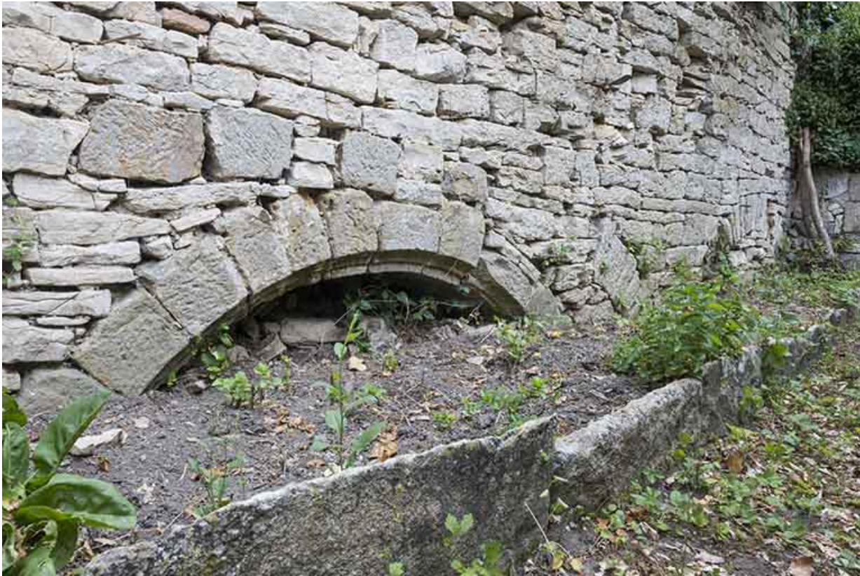
Voûte de l'ancienne galerie du cloître (?).
