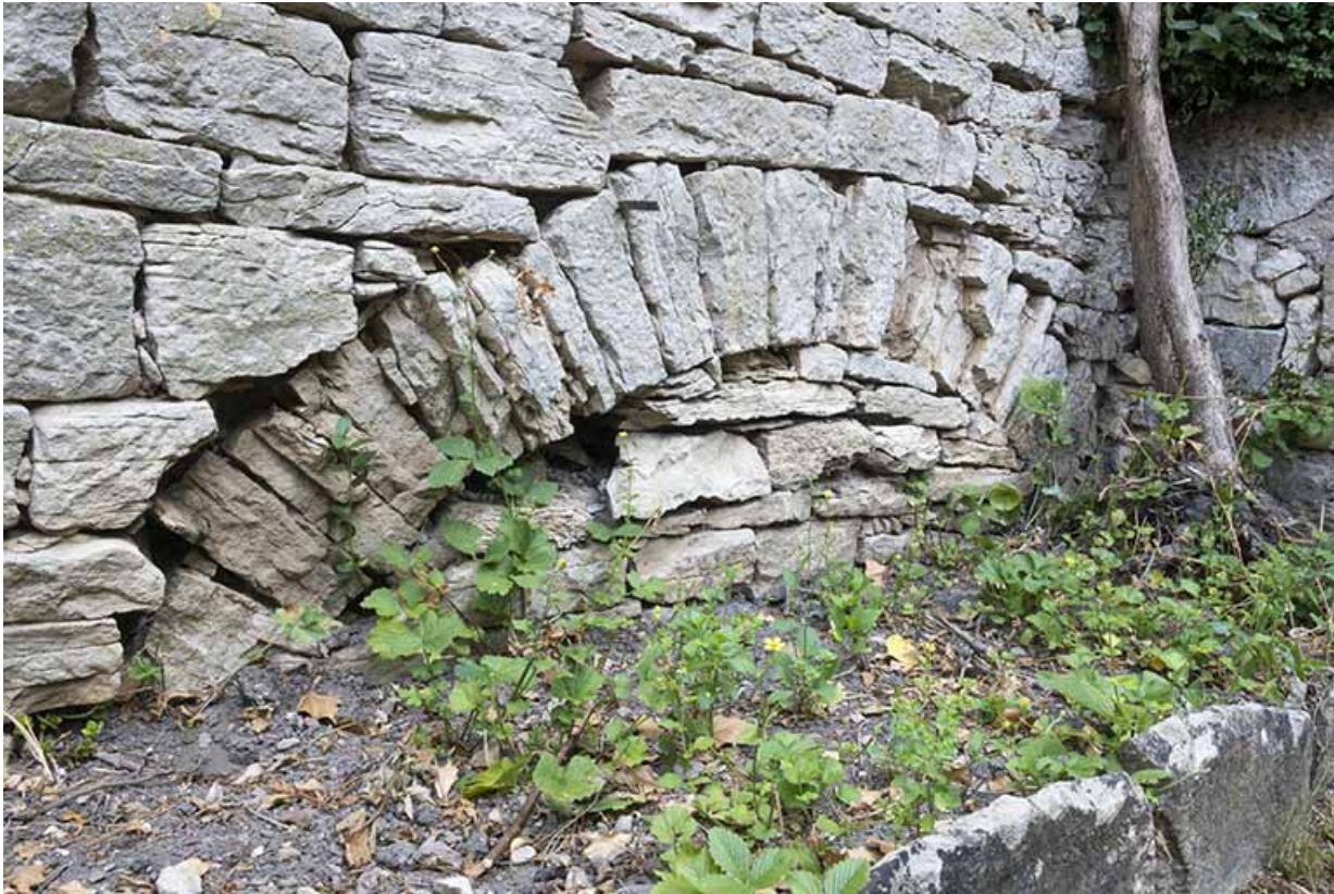
Détail sur la maçonnerie d'une voûte.
