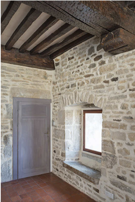
Détail sur le plafond à la française, premier étage. 70, Port-sur-Saône rue de l' Église
