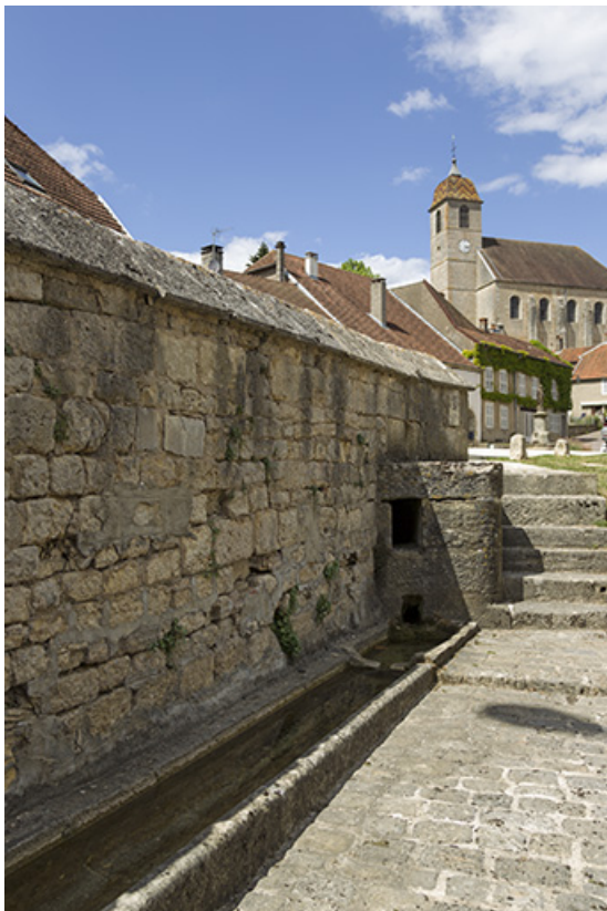
Fontaine-lavoir, 1 rue du Pâquis : l'arrivée d'eau. 70, Rupt-sur-Saône
