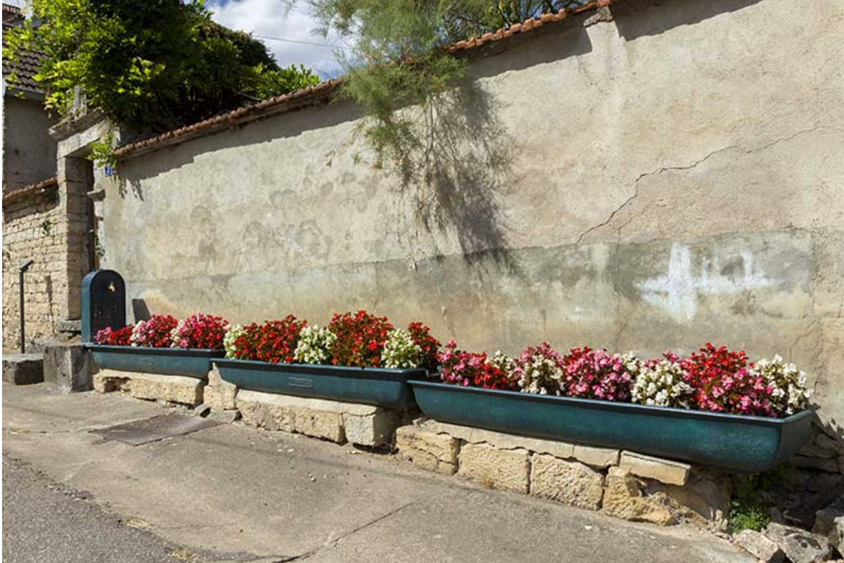
Fontaine-abreuvoirs, 4 rue de la Garenne. 70, Rupt-sur-Saône
