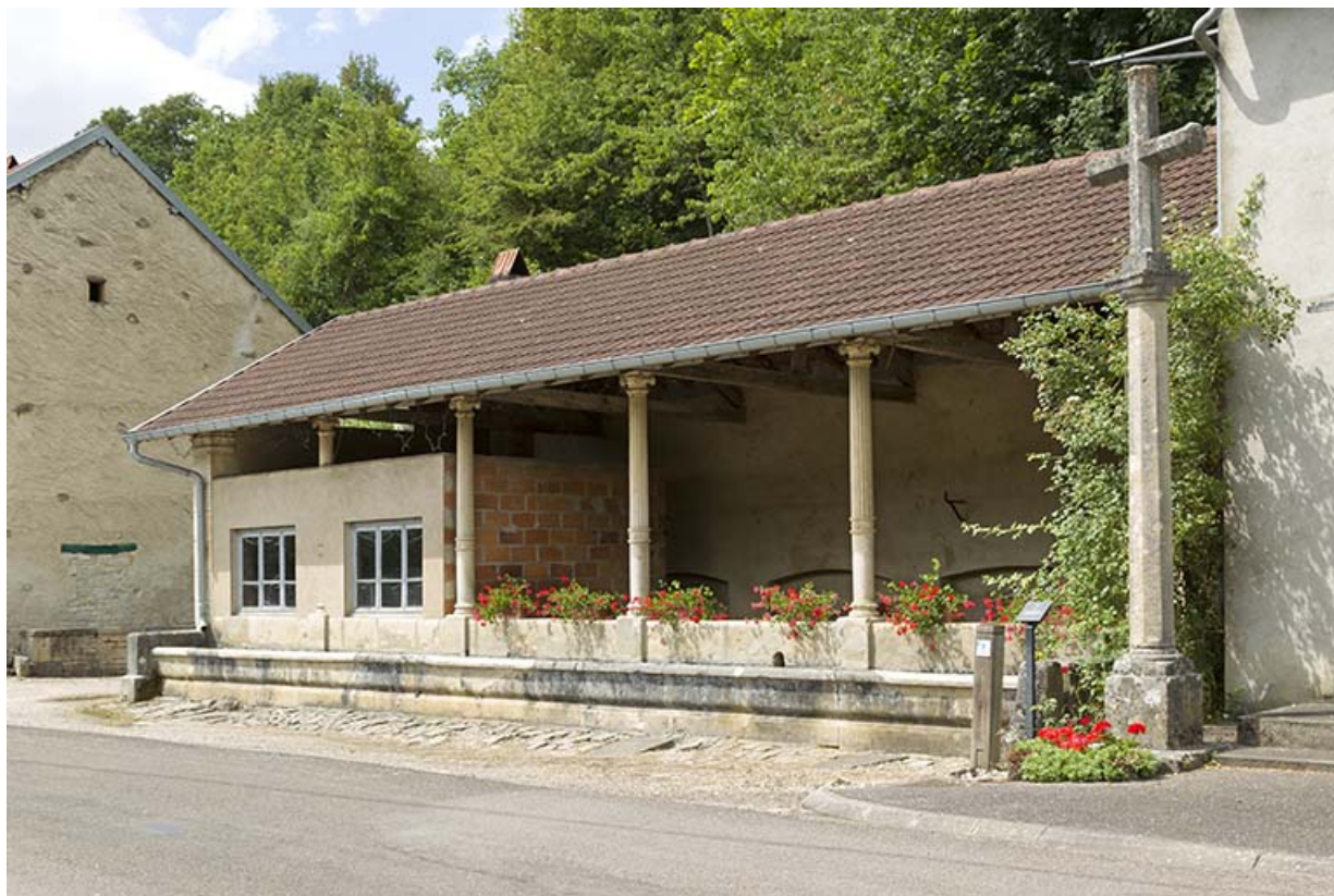
Fontaine, lavoir et abreuvoir, rue de la Fontenotte. 70, Rupt-sur-Saône
