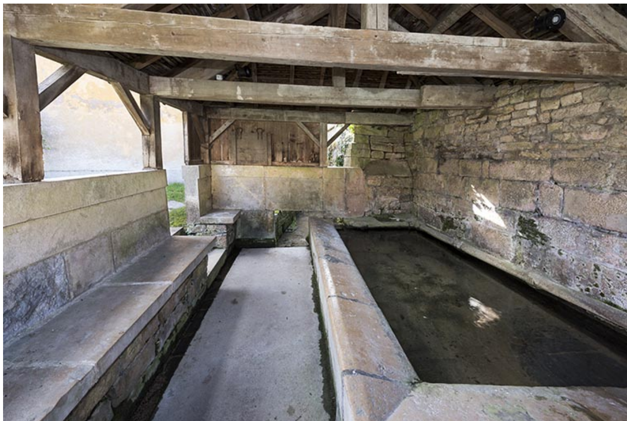
Fontaine-lavoir, 1 rue du Pâquis : intérieur du lavoir, montrant le banc et le bassin. 70, Rupt-sur-Saône
