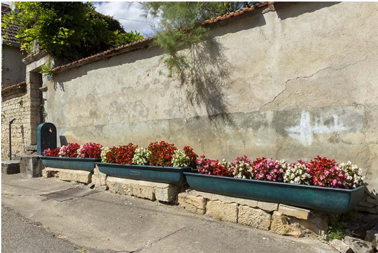
Fontaine-abreuvoirs, 4 rue de la Garenne. 70, Rupt-sur-Saône
