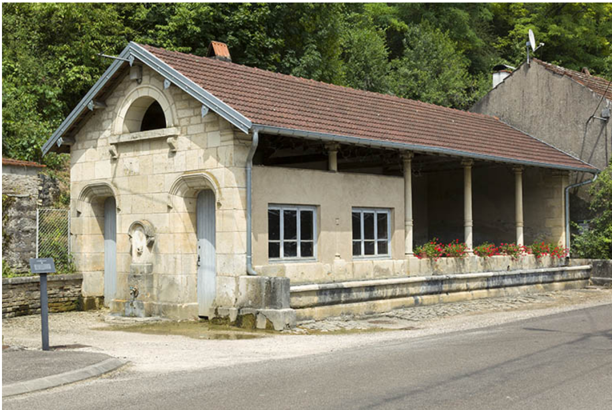
Fontaine, lavoir et abreuvoir, rue de la Fontenotte : vue de trois-quart. 70, Rupt-sur-Saône
