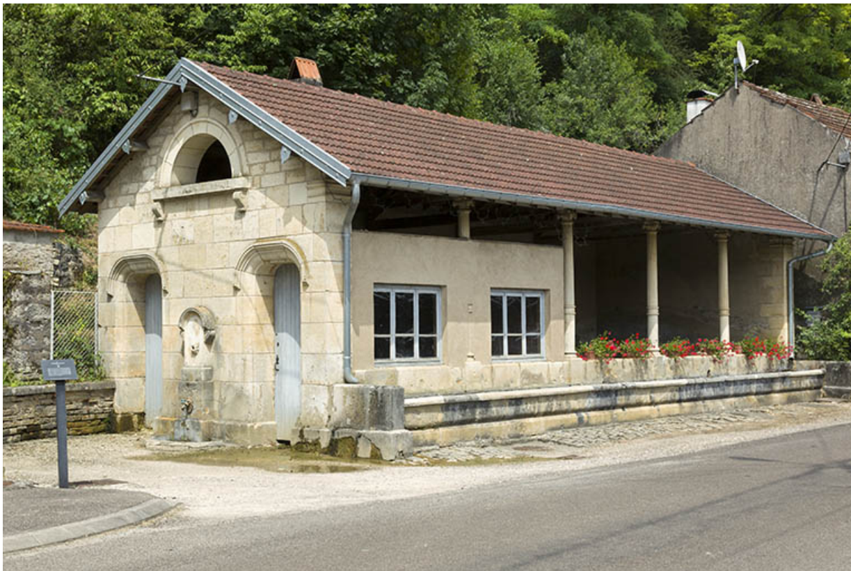
Fontaine, lavoir et abreuvoir, rue de la Fontenotte : vue de trois-quart. 70, Rupt-sur-Saône
