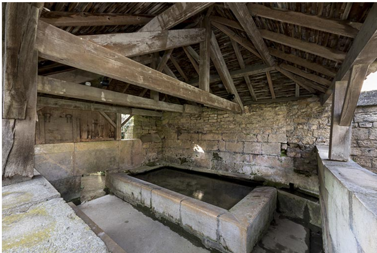
Fontaine-lavoir, 1 rue du Pâquis : intérieur du lavoir. 70, Rupt-sur-Saône
