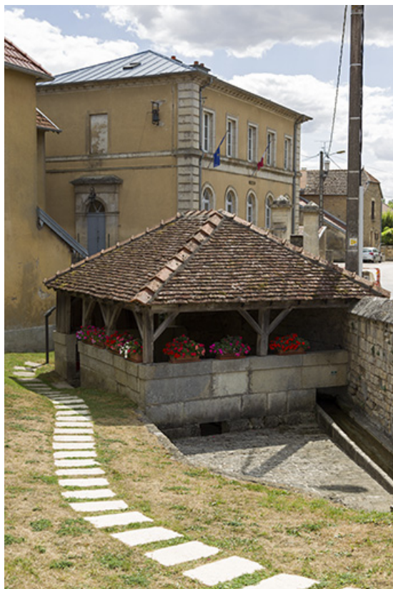
Fontaine-lavoir, 1 rue du Pâquis.
