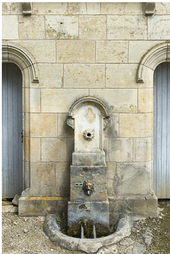
Fontaine, lavoir et abreuvoir, rue de la Fontenotte : borne fontaine. 70, Rupt-sur-Saône
