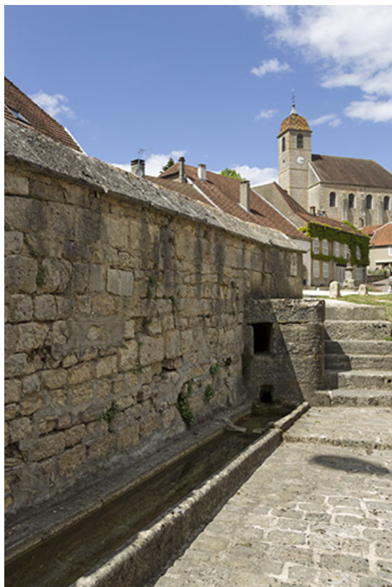
Fontaine-lavoir, 1 rue du Pâquis : l'arrivée d'eau. 70, Rupt-sur-Saône
