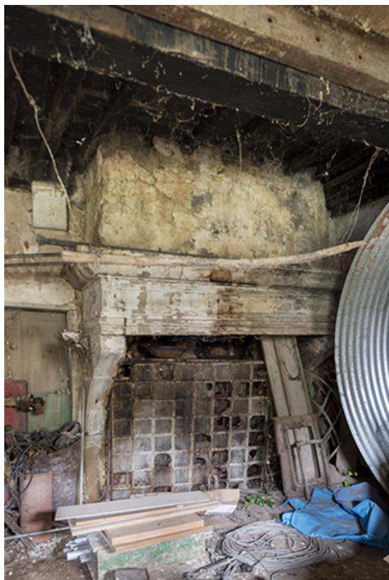
Cheminée adossée, au rez-de-chaussée de l'ancien logis. 70, Vouécourt
