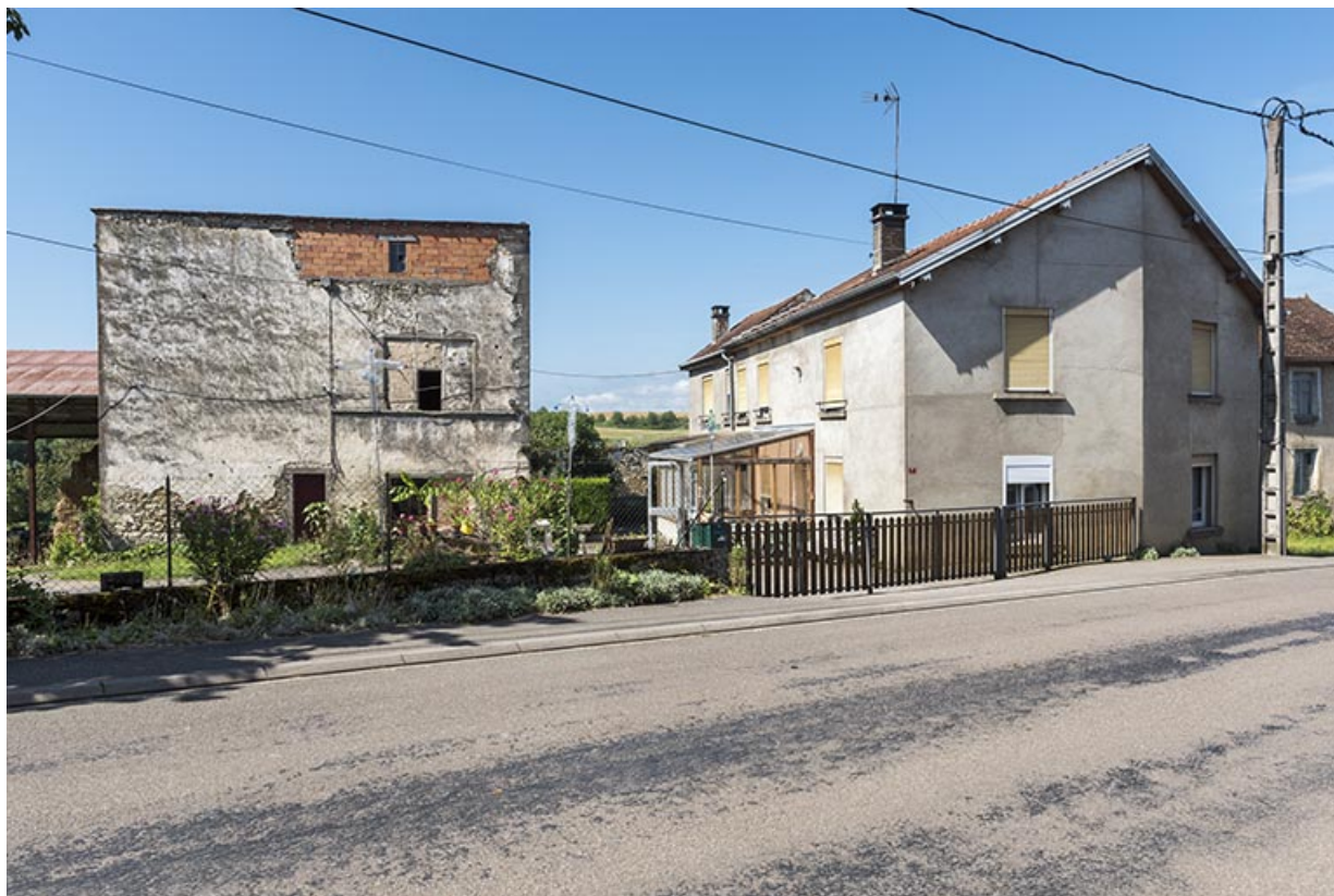
Vue d'ensemble depuis la rue des Vosges au nord-est. 70, Vougécourt
