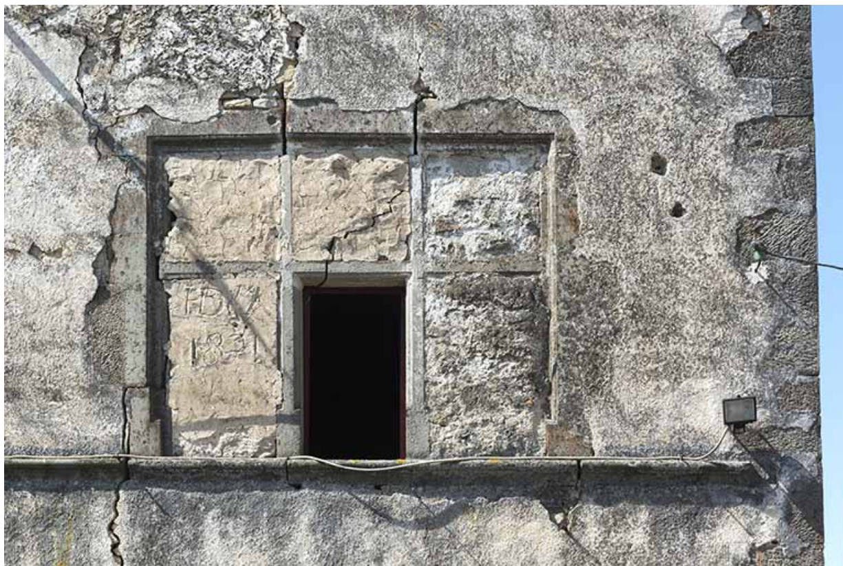
Détail de baie de la façade antérieure nord-est. 70, Vougécourt
