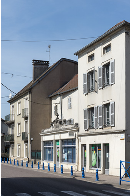
Immeubles le long de la rue principale. 70, Port-sur-Saône
