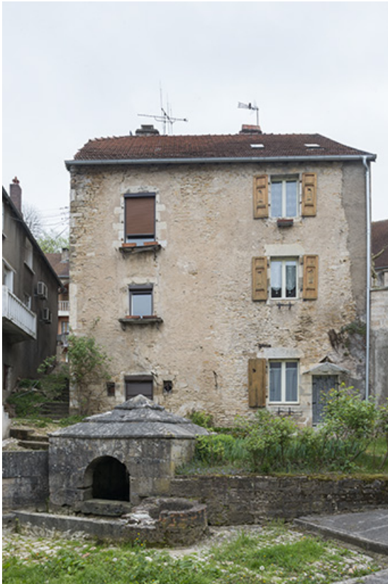
Le "vieux Port-sur-Saône", rue de la Fontaine. 70, Port-sur-Saône
