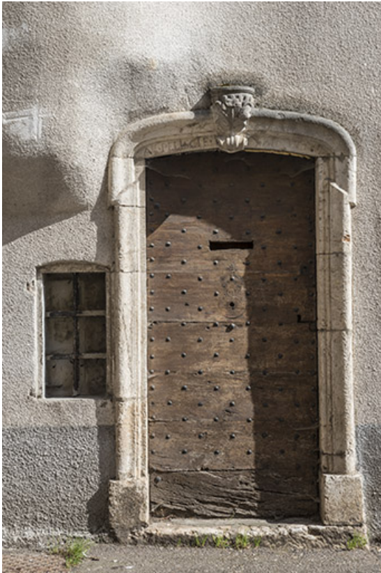
Porte avec linteau en arc surbaissé.
