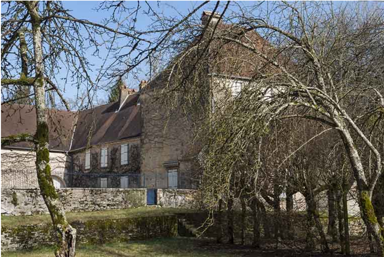
Partie donnant sur la cour intérieure de l'édifice.
