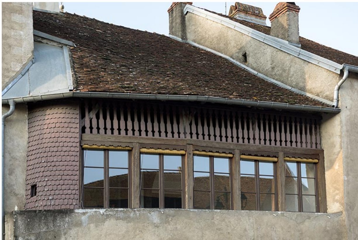
Détail de la façade antérieure : l'ancien séchoir à maïs.
