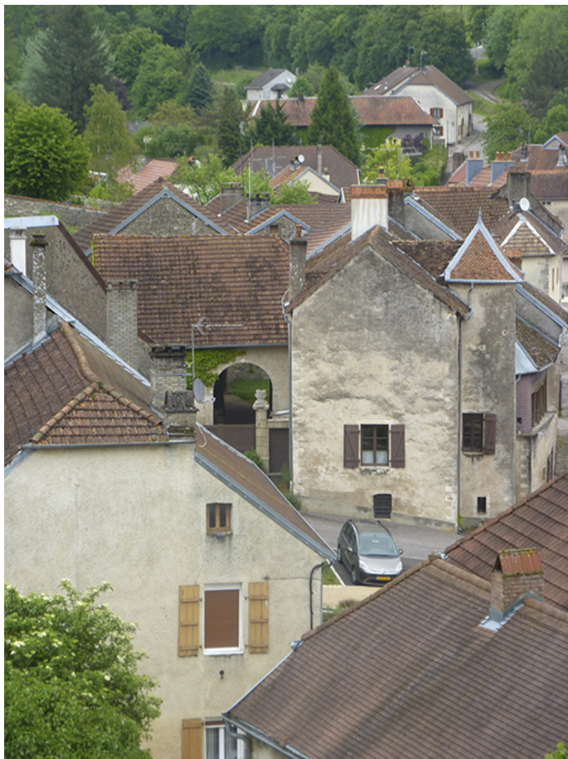
Vue générale rapprochée depuis le château. 70, Rupt-sur-Saône, 2 chemin de la Vigne Rouge
