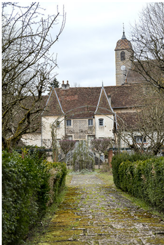
Vue rapprochée de la façade postérieure, depuis le chemin du Petit Breuil. 70, Rupt-sur-Saône, 4 rue de la Dame Blanche
