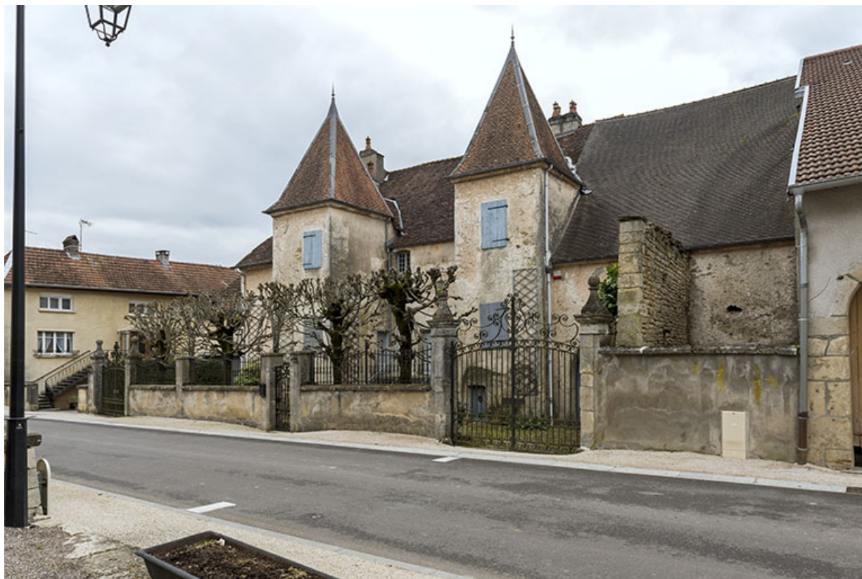
La demeure Lange de Ferrière, 4 rue de la Dame Blanche. 70, Rupt-sur-Saône
