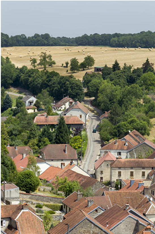
Rue de la Dame Blanche et emplacement du couvent (détruit). 70, Rupt-sur-Saône
