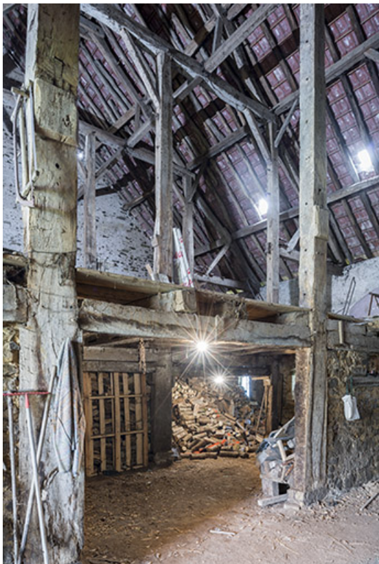
Détail des fermes de la charpente de la grange 70, Baulay, 32-34 Grande Rue
