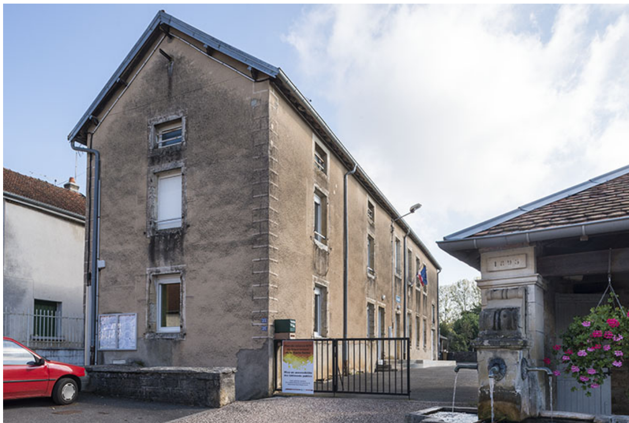
Vue sur le pignon depuis la rue.
