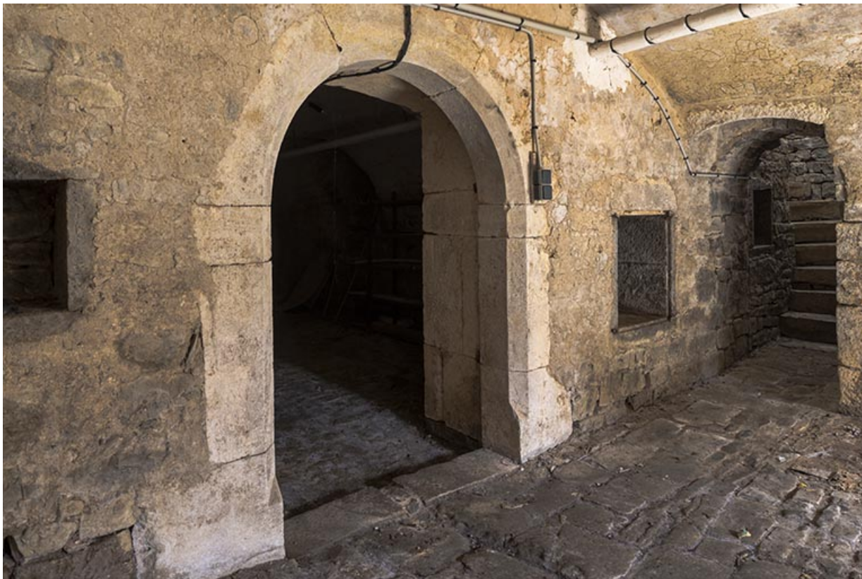
Porte de séparation de la cave.
