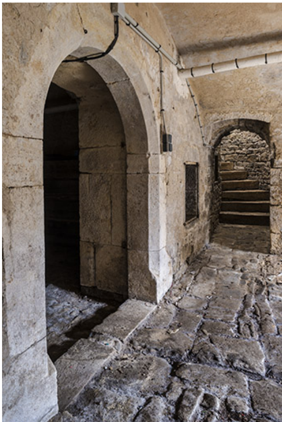
Escalier d'accès au rez-de-chaussée de la maison.
