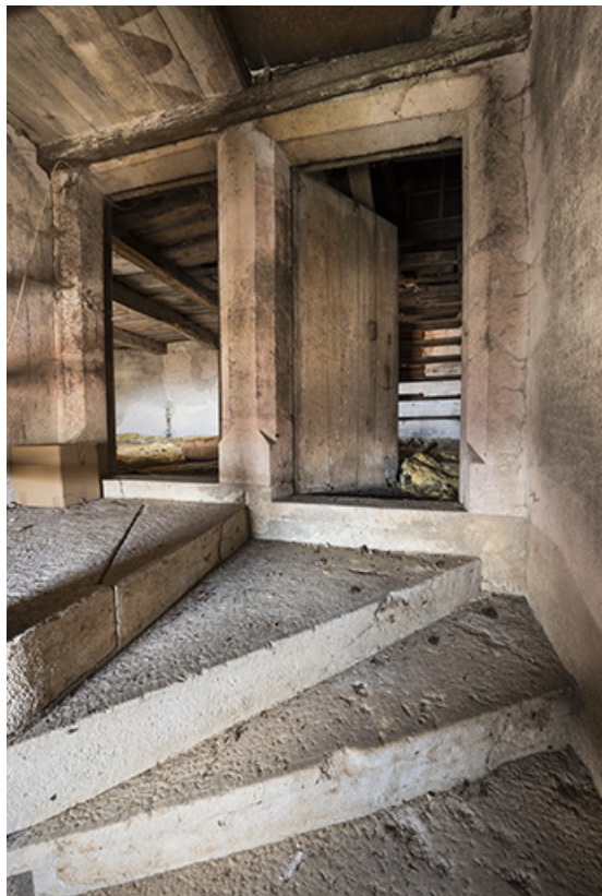
Portes d'accès aux combles depuis la tour.
