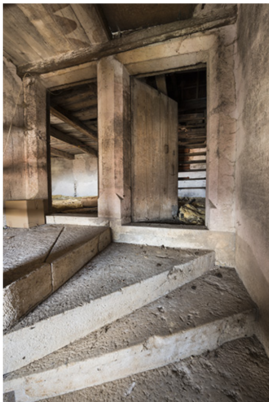
Portes d'accès aux combles depuis la tour.
