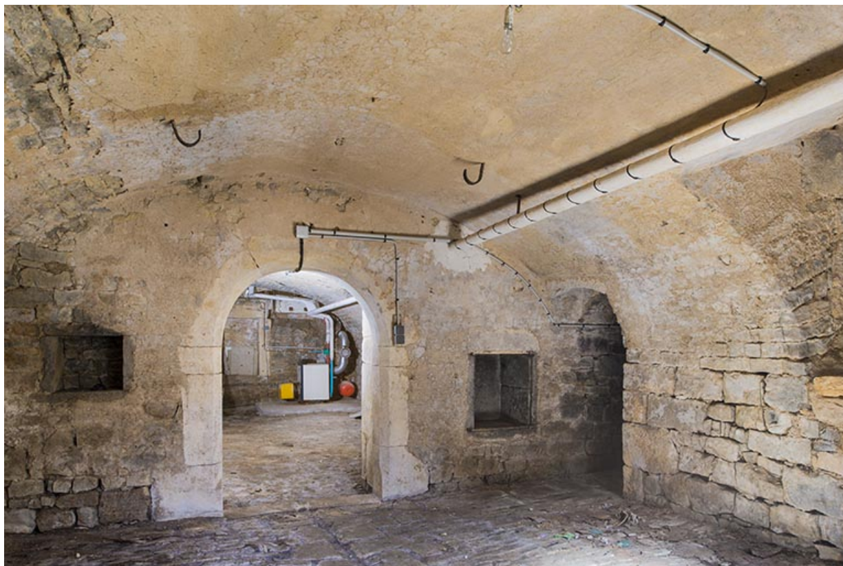
Vue depuis la porte d'accès de la cave située sur le mur pignon Sud.
