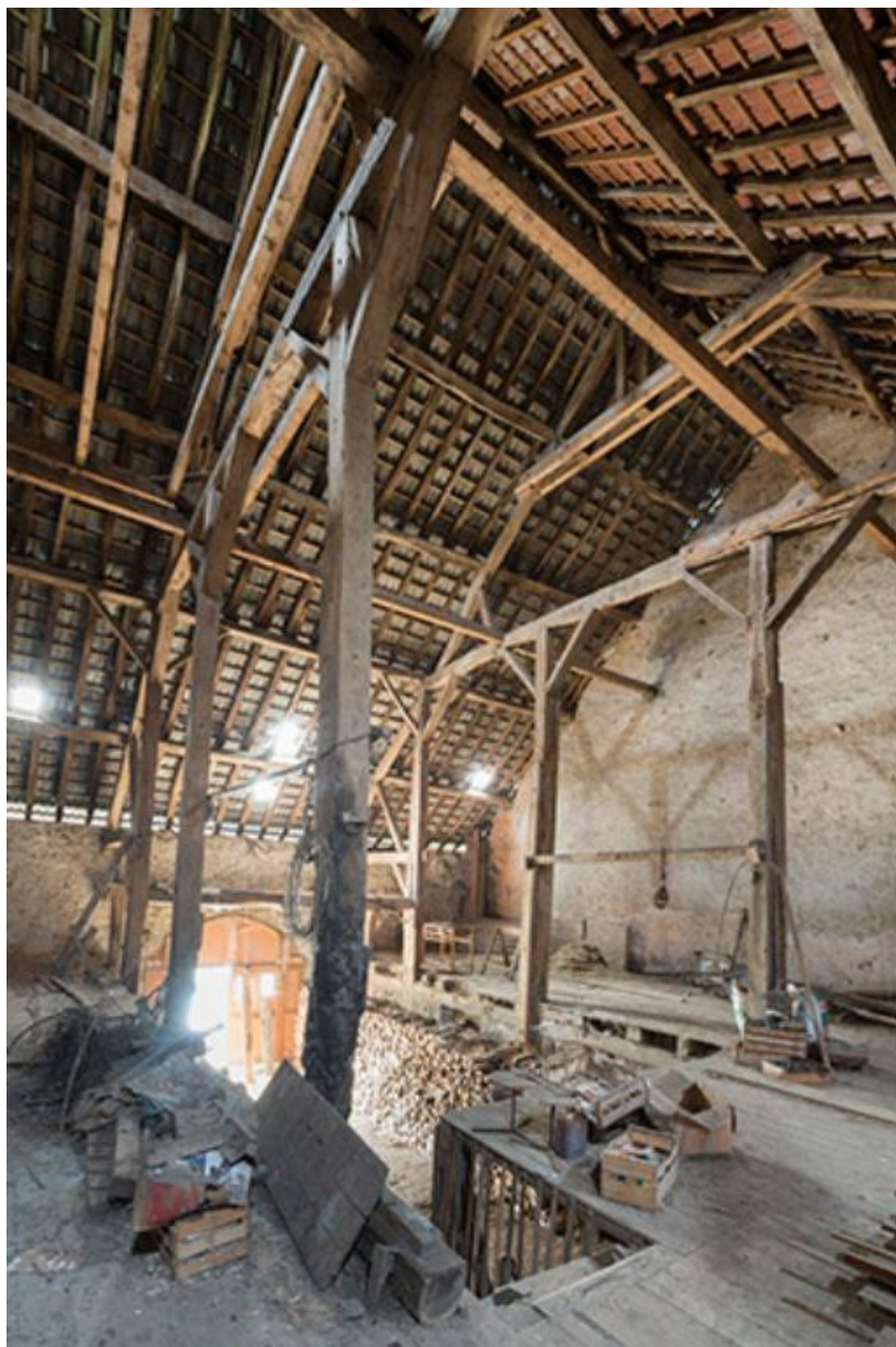
Charpente de la ferme, vue du grenier, 13 Grande rue. 70, Baulay
