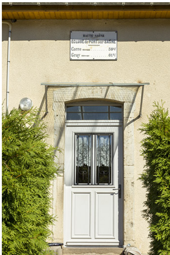
Porte d'entrée de la maison d'éclusier et sa plaque signalétique des distances d'écluses. 70, Port-sur-Saône chemin communal du Pré de la Maladière
