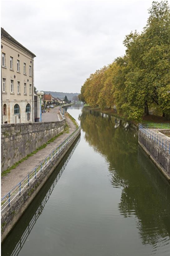
La dérivation depuis le pont de la porte de garde. 70, Port-sur-Saône
