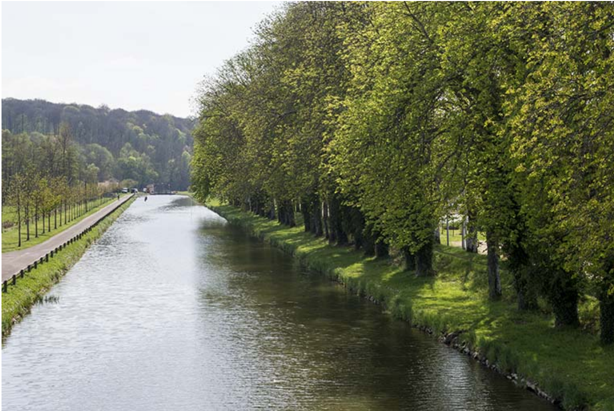
Vue générale du canal vers l'aval.
