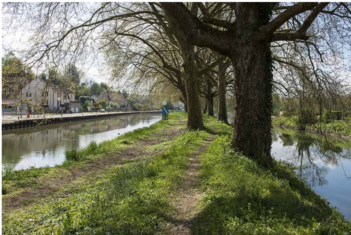
La digue séparant le canal de la rivière. 70, Port-sur-Saône
