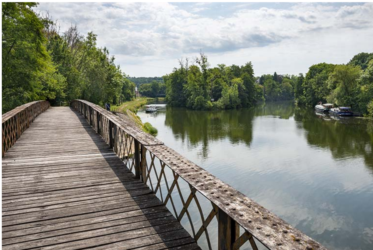
Début du bief de Port-sur-Saône ; vue depuis le pont de la Lanterne à Conflandey. 70, Port-sur-Saône
