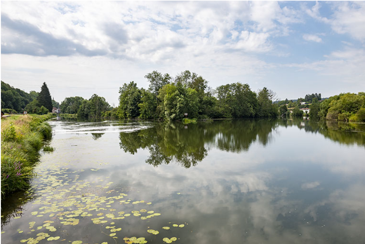
Entrée amont de la dérivation sur la gauche. 70, Port-sur-Saône
