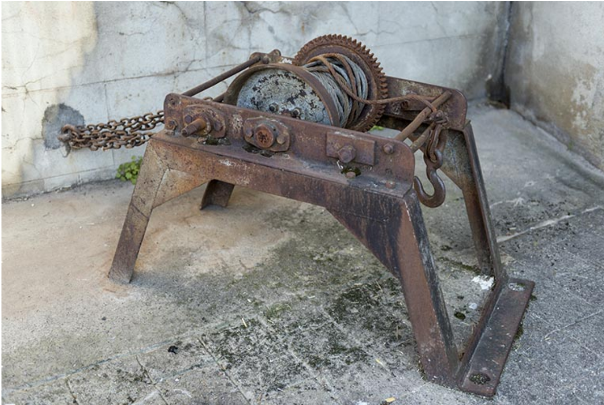
Le treuil qui permettait d'actionner les portes de garde. 70, Port-sur-Saône
