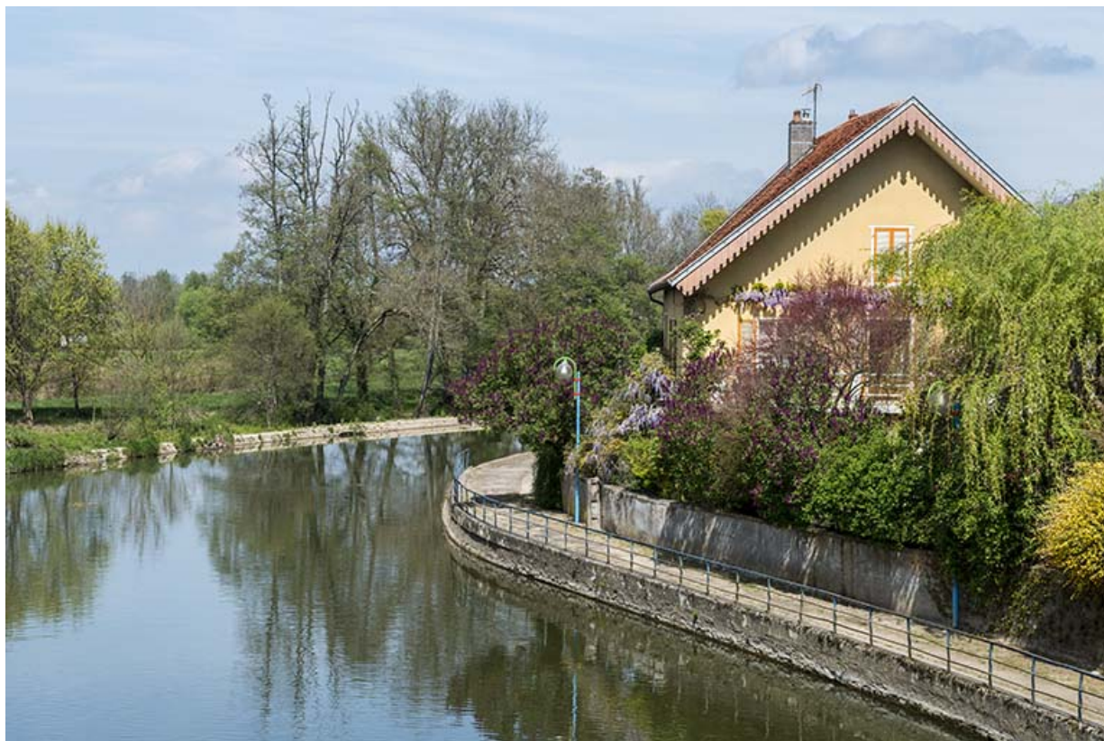
Vue sur le canal en amont de la porte de garde. 70, Port-sur-Saône
