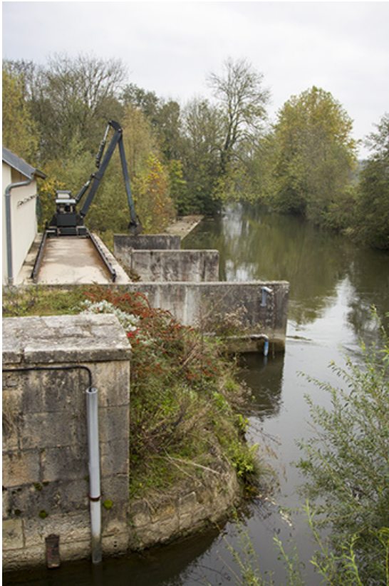
Appareil lié à l'entretien du canal.
