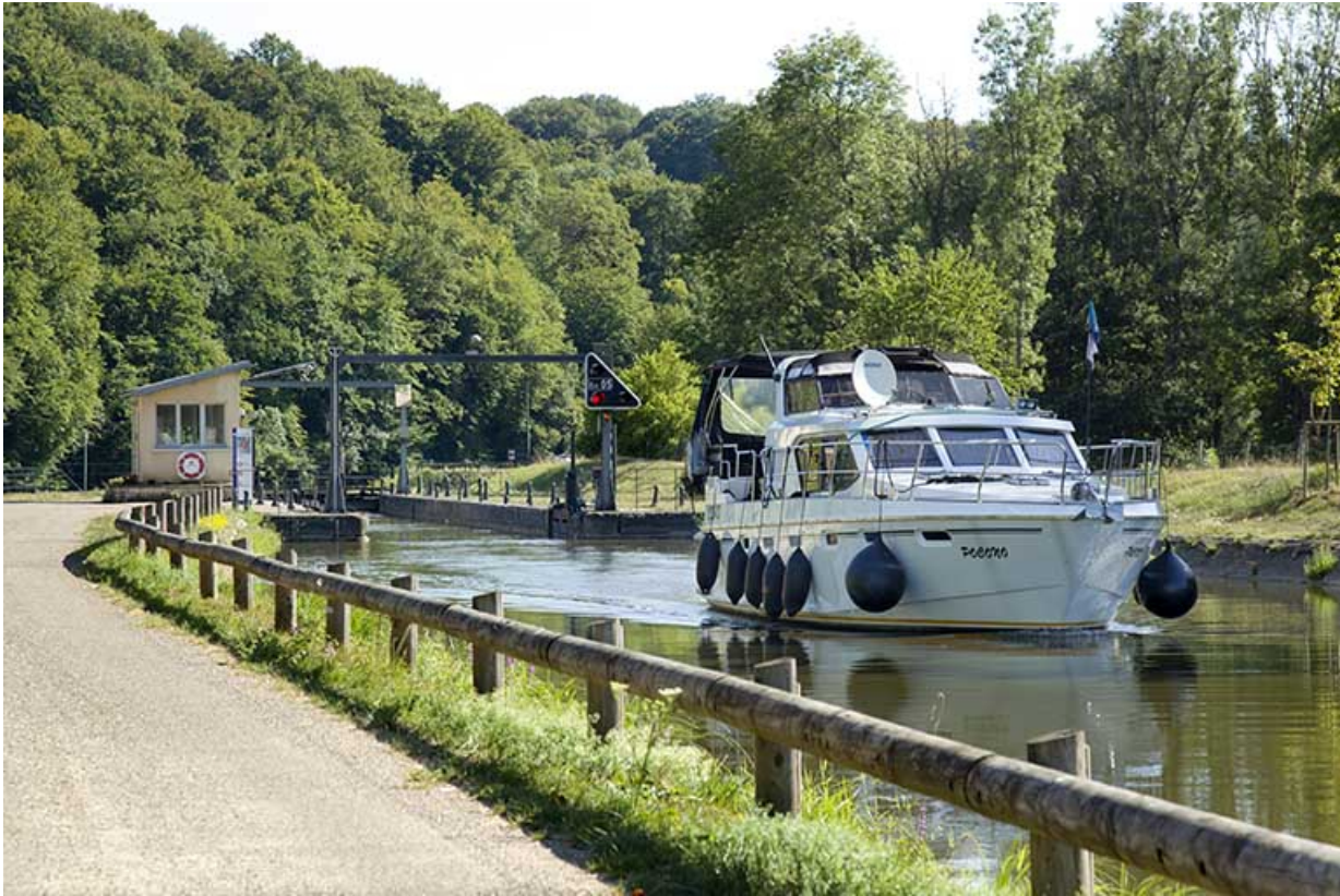
L'écluse de Port-sur-Saône.
