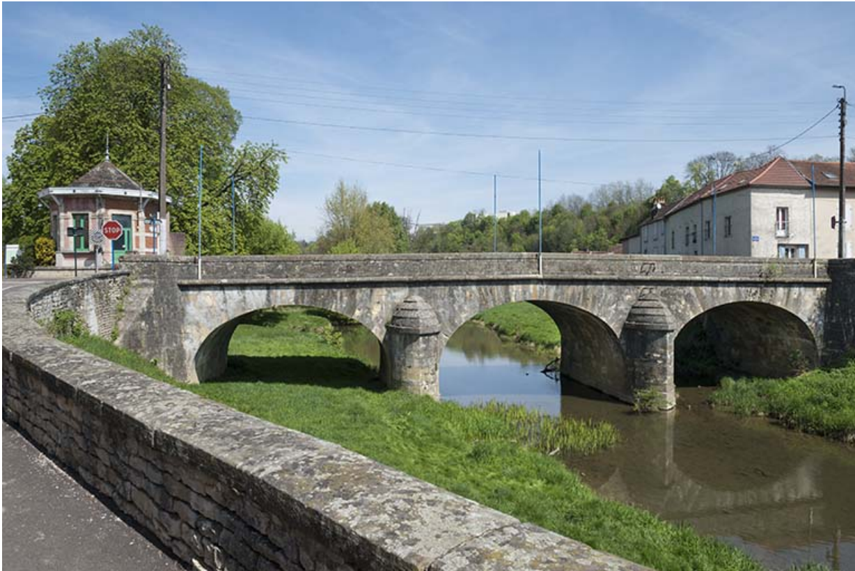
Le pont au niveau de la Rezelle. 70, Port-sur-Saône
