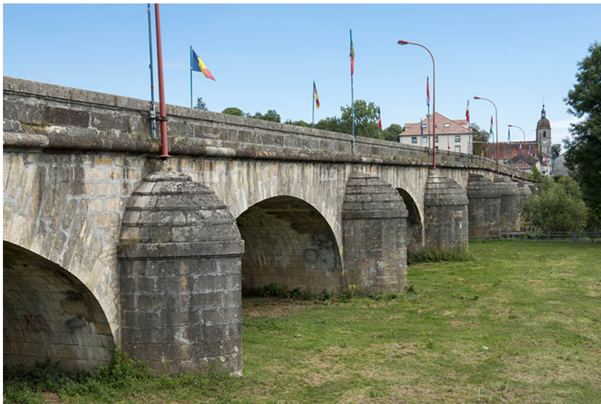
Le pont au niveau de Saint-Valère.
