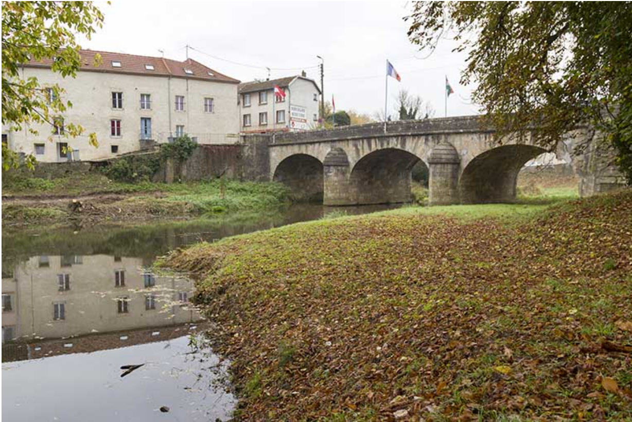
Le pont depuis l'amont. 70, Port-sur-Saône
