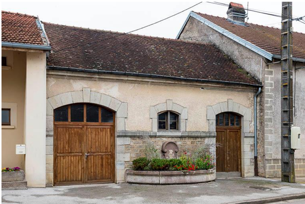
La façade sur rue du lavoir et remise de pompe à incendie, rue des Vignes 70, Baulay
