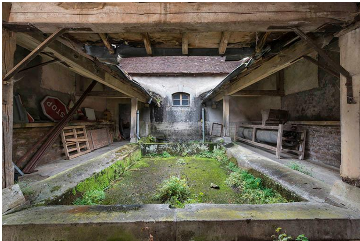
Le bassin du lavoir entouré de sa galerie couverte, dans le prolongement de la remise de pompe à incendie. 70, Baulay
