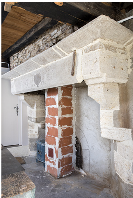
Intérieur du premier logis : cheminée de l'ancienne cuisine.
