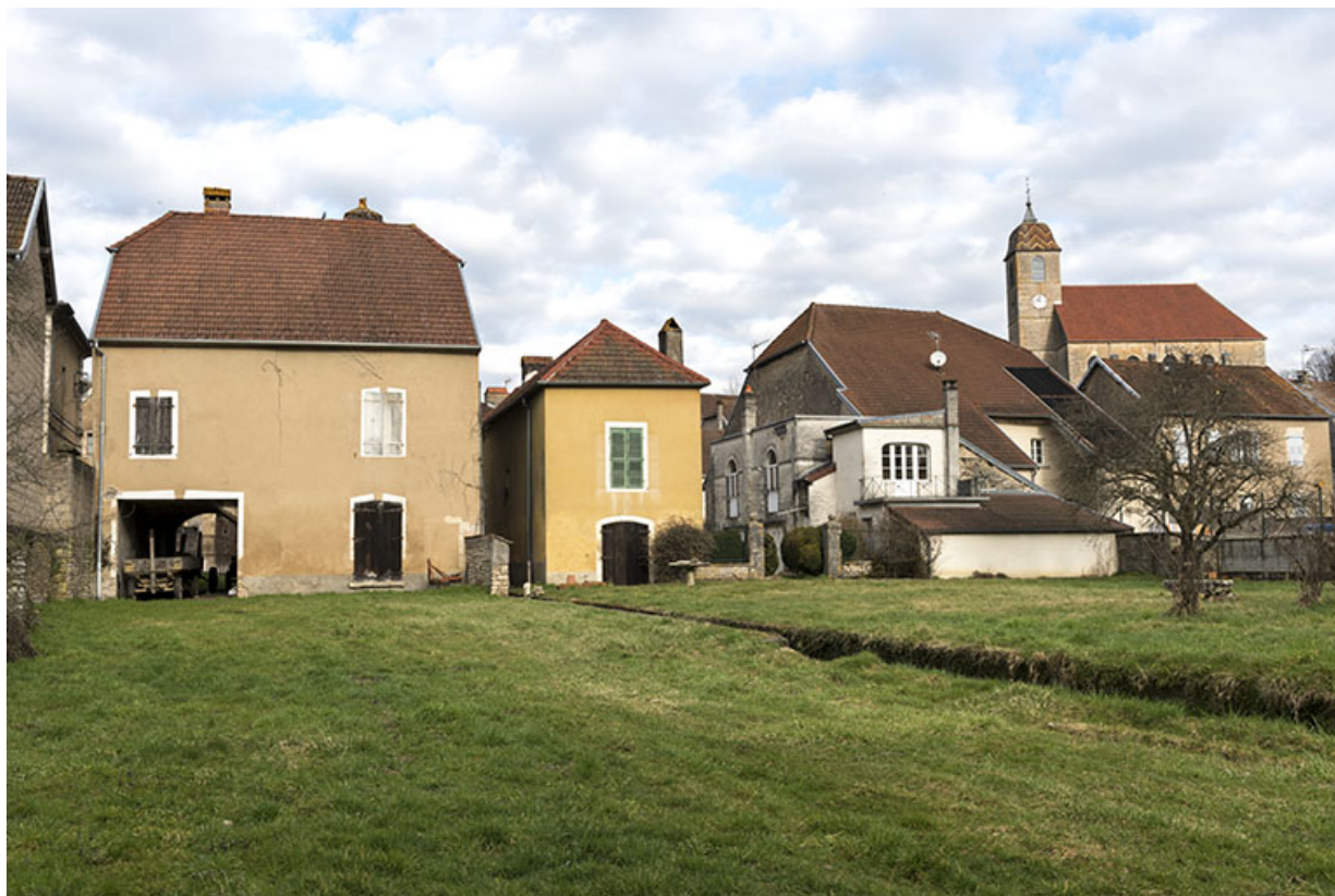
Ferme (?) avec boutique, 3 rue du Pâquis : façade postérieure. 70, Rupt-sur-Saône
