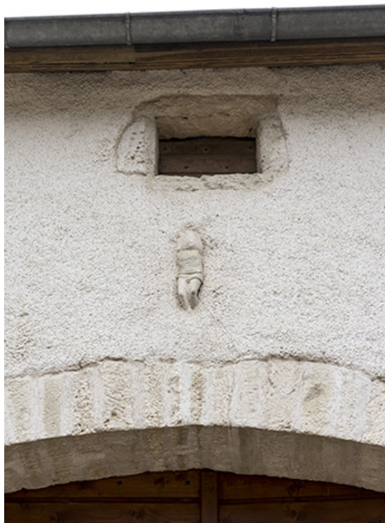
Ferme-bloc, 8 rue de la Garenne : fragment de calvaire (Christ en croix) en réemploi. 70, Rupt-sur-Saône
