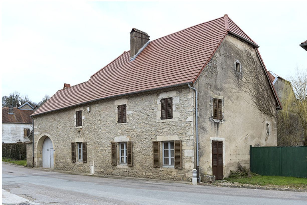
Ferme-bloc (modifiée), 18 rue de la Dame Blanche. 70, Rupt-sur-Saône
