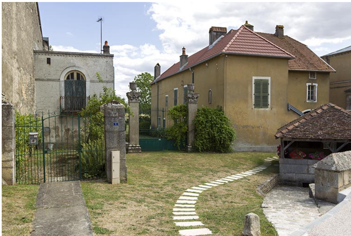
Ferme (?) avec boutique, 3 rue du Pâquis : vue de trois quarts gauche. 70, Rupt-sur-Saône
