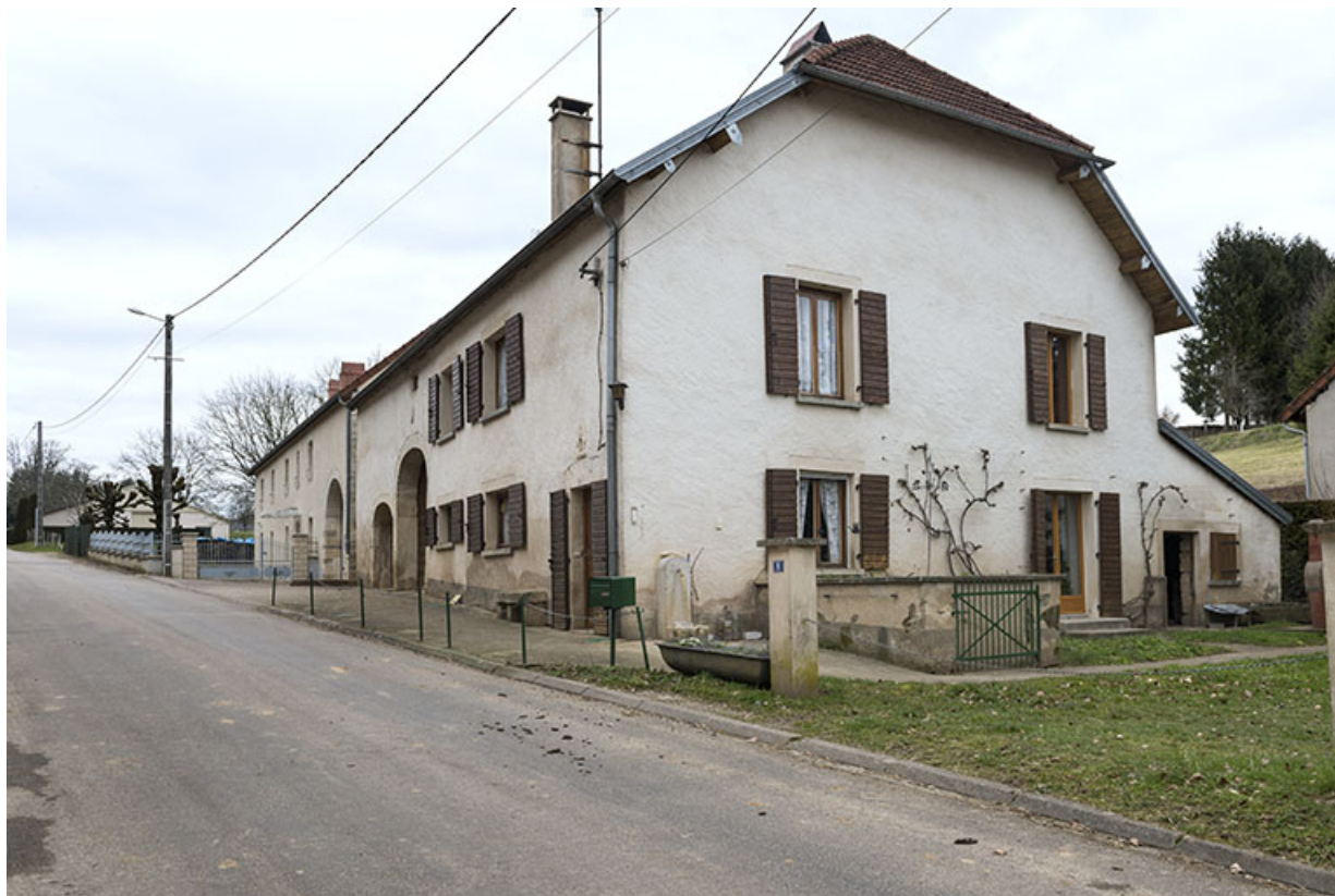
Ferme-bloc, 8 rue de la Garenne. 70, Rupt-sur-Saône
