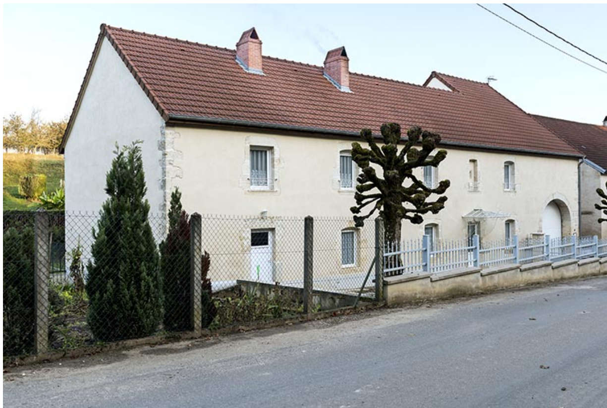
Ferme-bloc, 10-14 rue de la Garenne. 70, Rupt-sur-Saône
