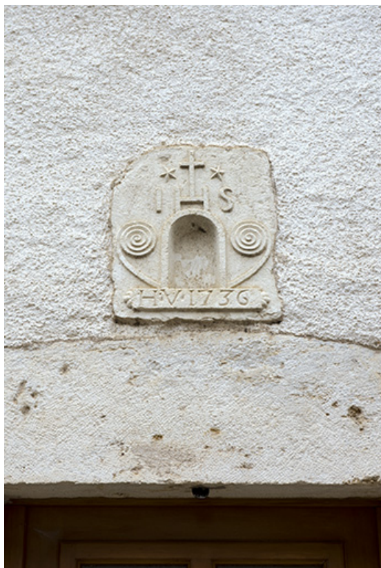
Ferme-bloc, 8 rue de la Garenne : niche en réemploi (?) portant la date 1736 et IHS au-dessus de la porte d'entrée. 70, Rupt-sur-Saône
