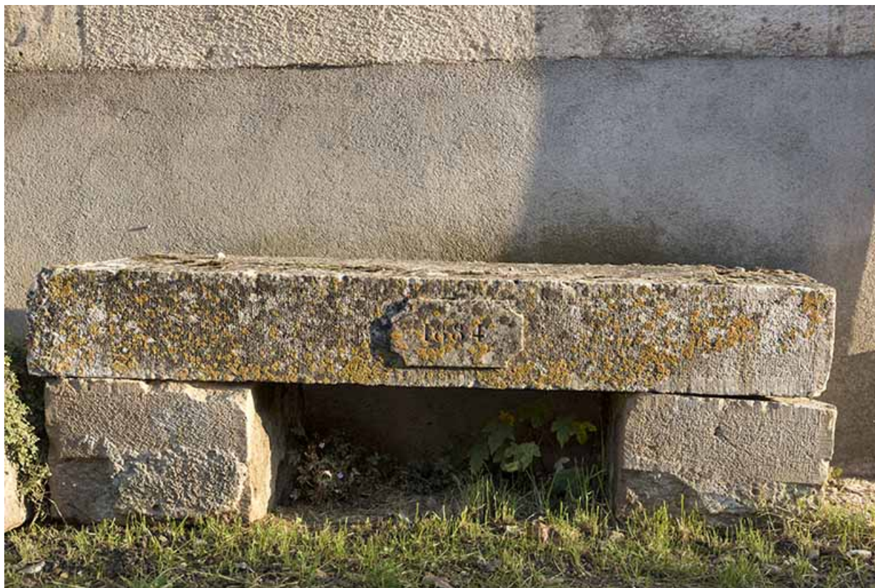
Ferme en retour d'équerre, 14-16 rue de la Dame Blanche : la date 1884 sur un linteau déposé servant de banc. 70, Rupt-sur-Saône
