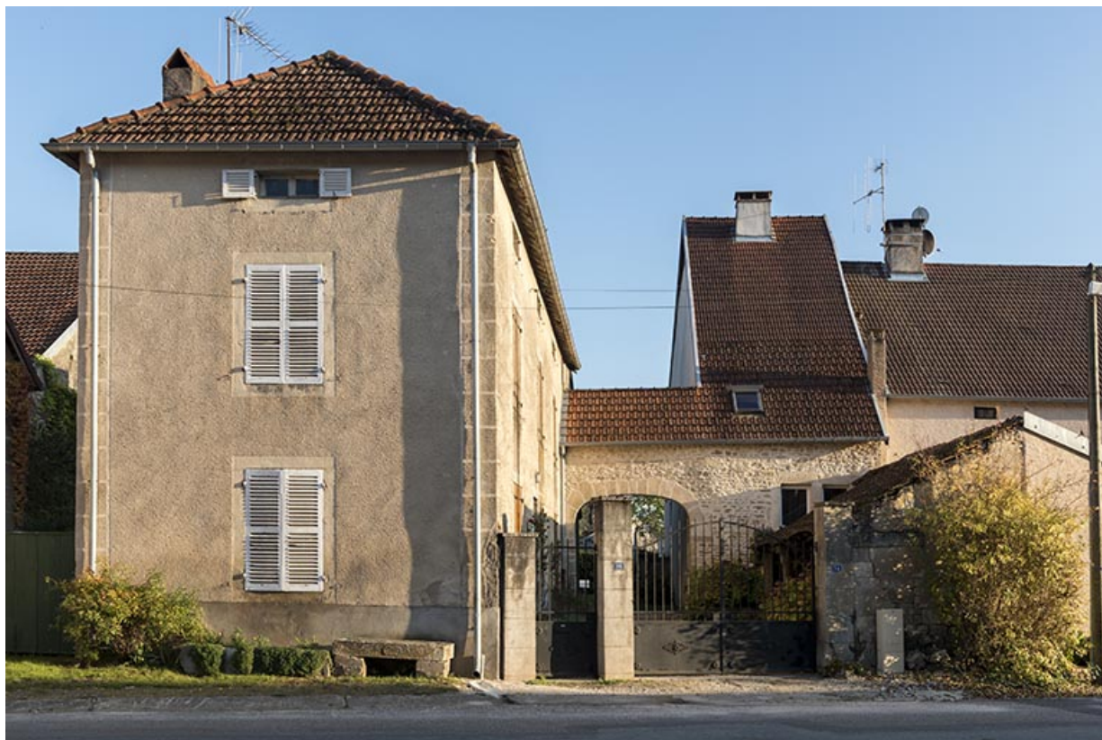
Ferme en retour d'équerre, 14-16 rue de la Dame Blanche. Le bâtiment abritant la grange et l'étable à vaches a été modifié. 70, Rupt-sur-Saône
