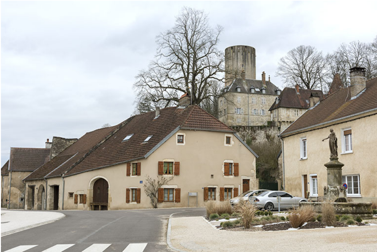
Ferme-bloc, 7 place de l'Abondance. L'étable à vaches et la grange sont sur le mur goutterau parallèle à la rue, le logis à un étage carré se prolonge sur le mur pignon.
