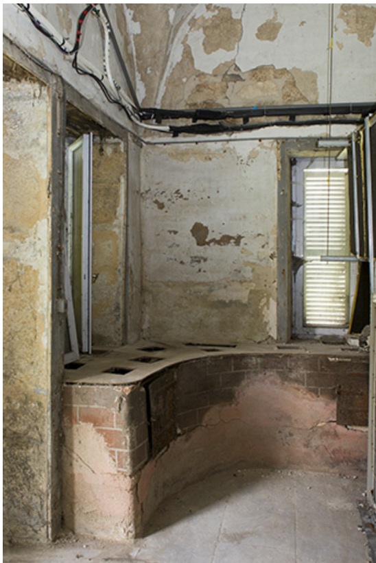
L'ancienne cuisine : détail du potager.
