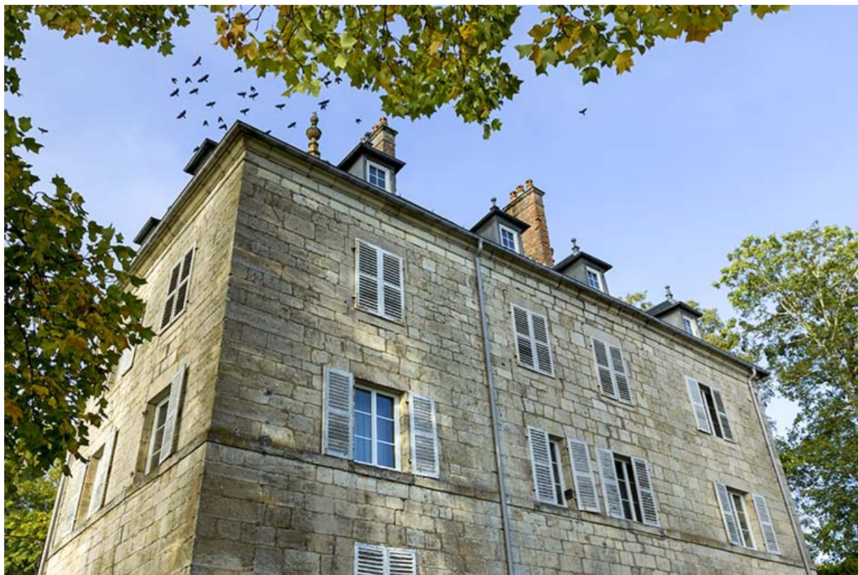
Façade postérieure et façade latérale droite.
