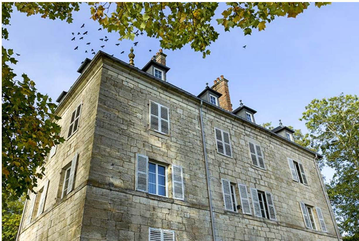
Façade postérieure et façade latérale droite.
