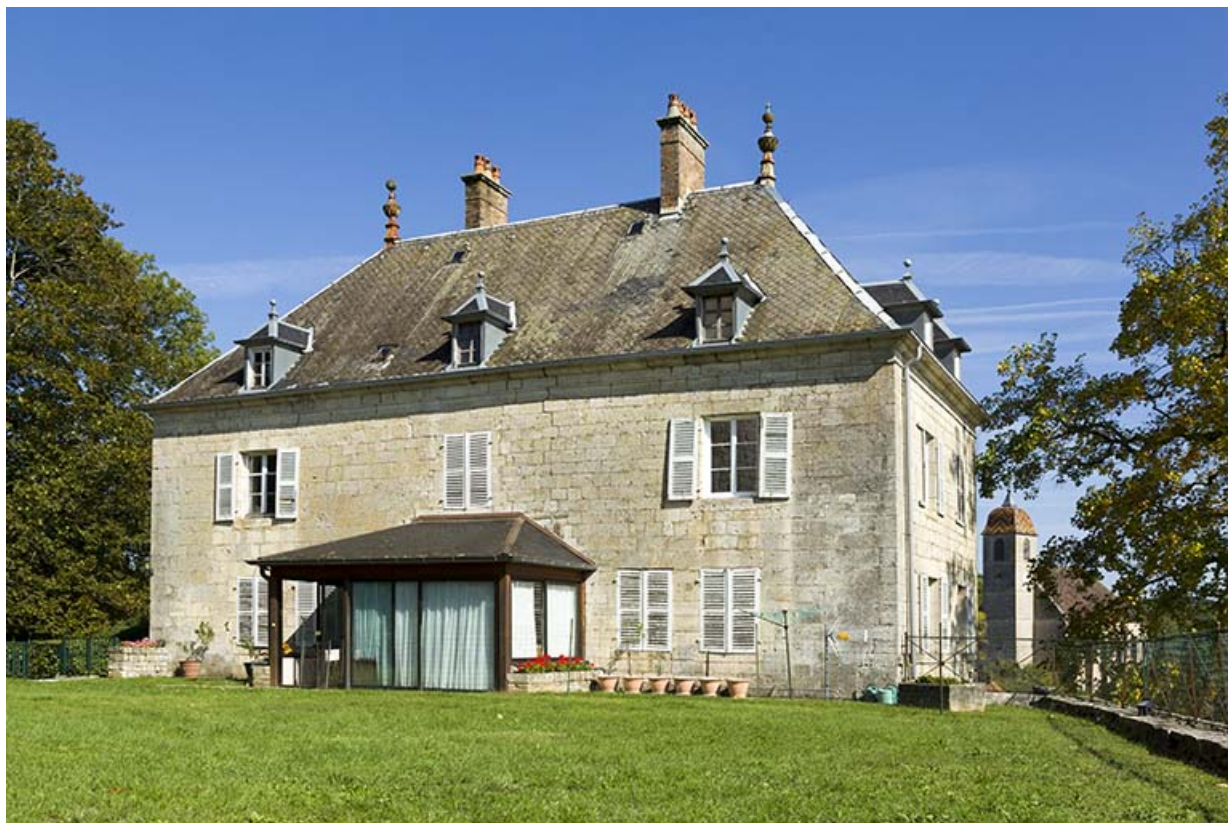
Façade antérieure et façade latérale droite.
