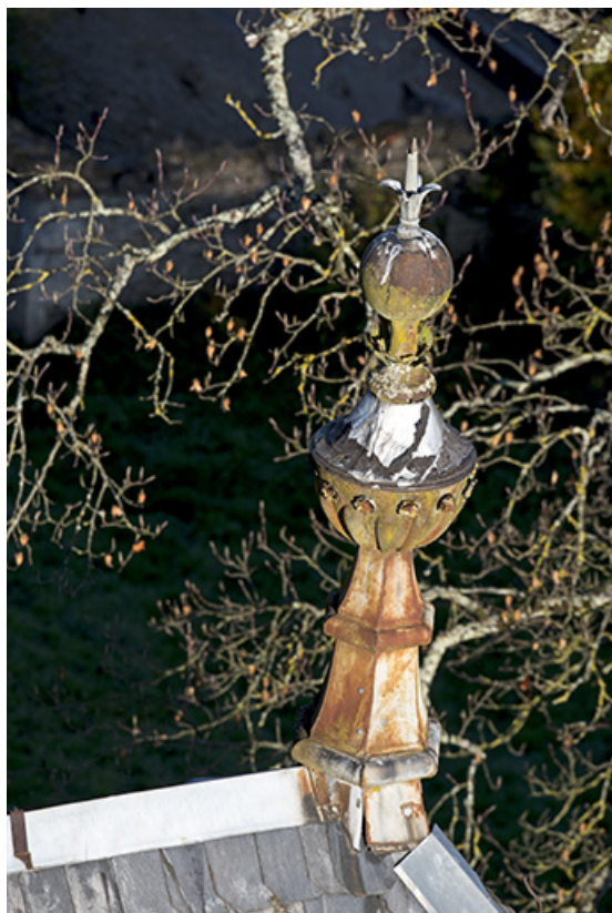
Détail : un des épis de faitage.
