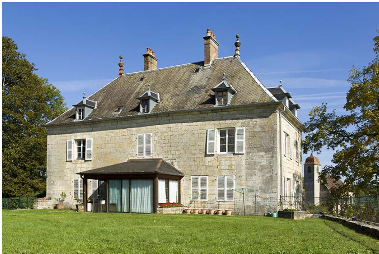
Façade antérieure et façade latérale droite.
