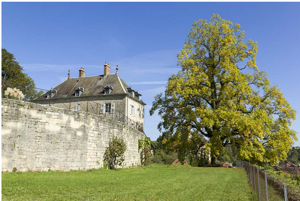
Vue générale depuis la 1ère terrasse, avec à droite le tulipier de Virginie.
