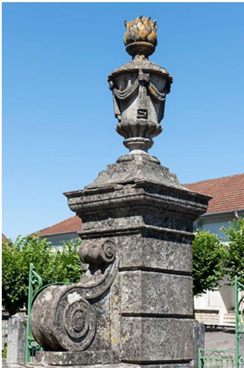
Détail du pilier du portail d'entrée de la mairie. Pot-à-feu et enroulement en volute décoratifs. 70, Baulay, 2 rue de l' Église
