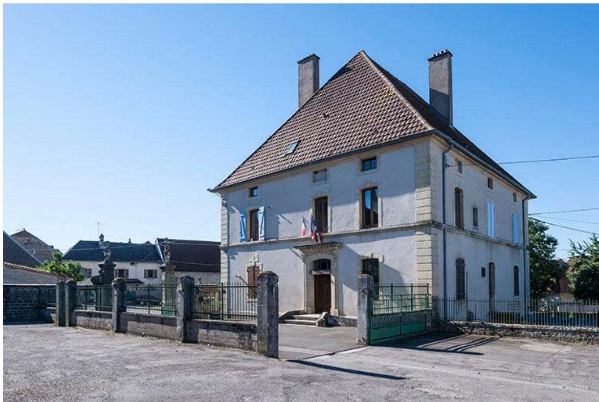
La mairie vue depuis la cour de récréation de l'école.
