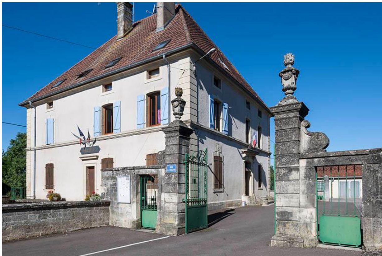
Mairie et son portail d'entrée, le décor et les murs de cloture hérités de la maison Malapert. 70, Baulay, 2 rue de l' Église
