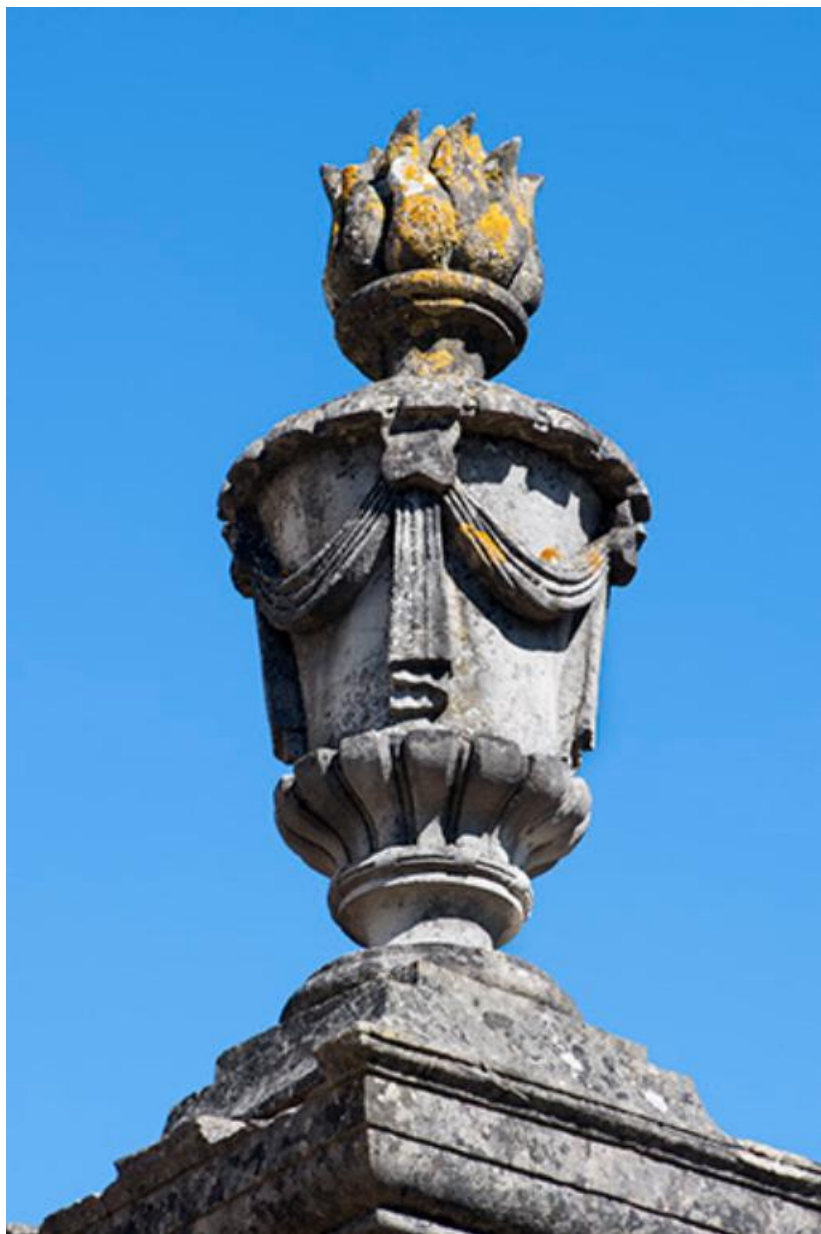
Détail d'un pot-à-feu décorant le mur de clôture de la mairie.
