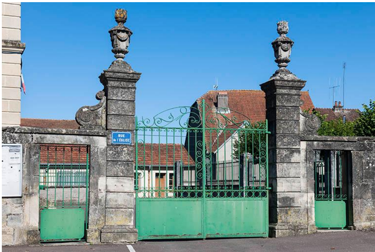
Portail d'entrée de la mairie.
