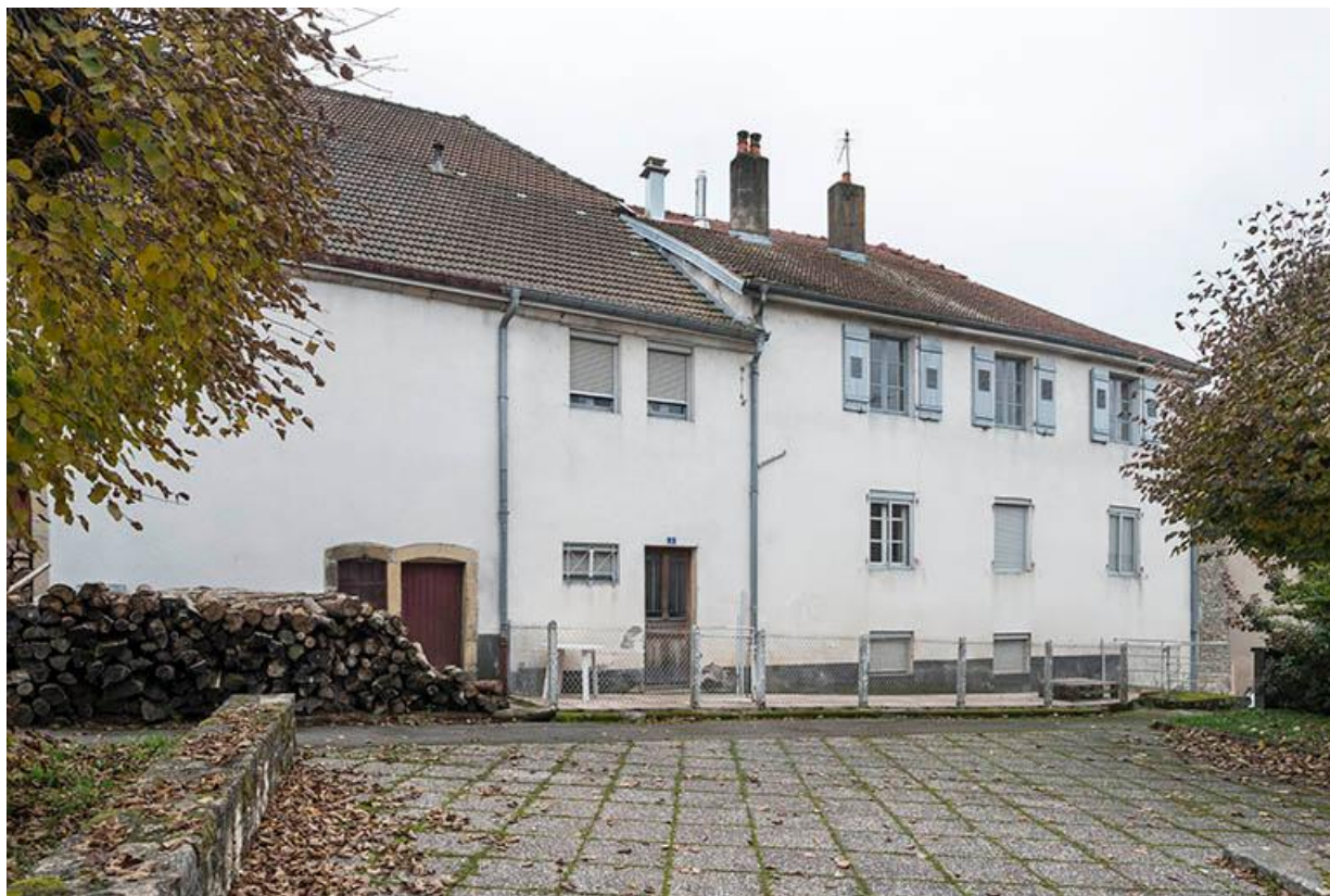
Ancienne école des filles et logement de l'institutrice. La place publique à côté de l'église, à l'emplacement de l'ancien cimetière, servait de cour de récréation.
