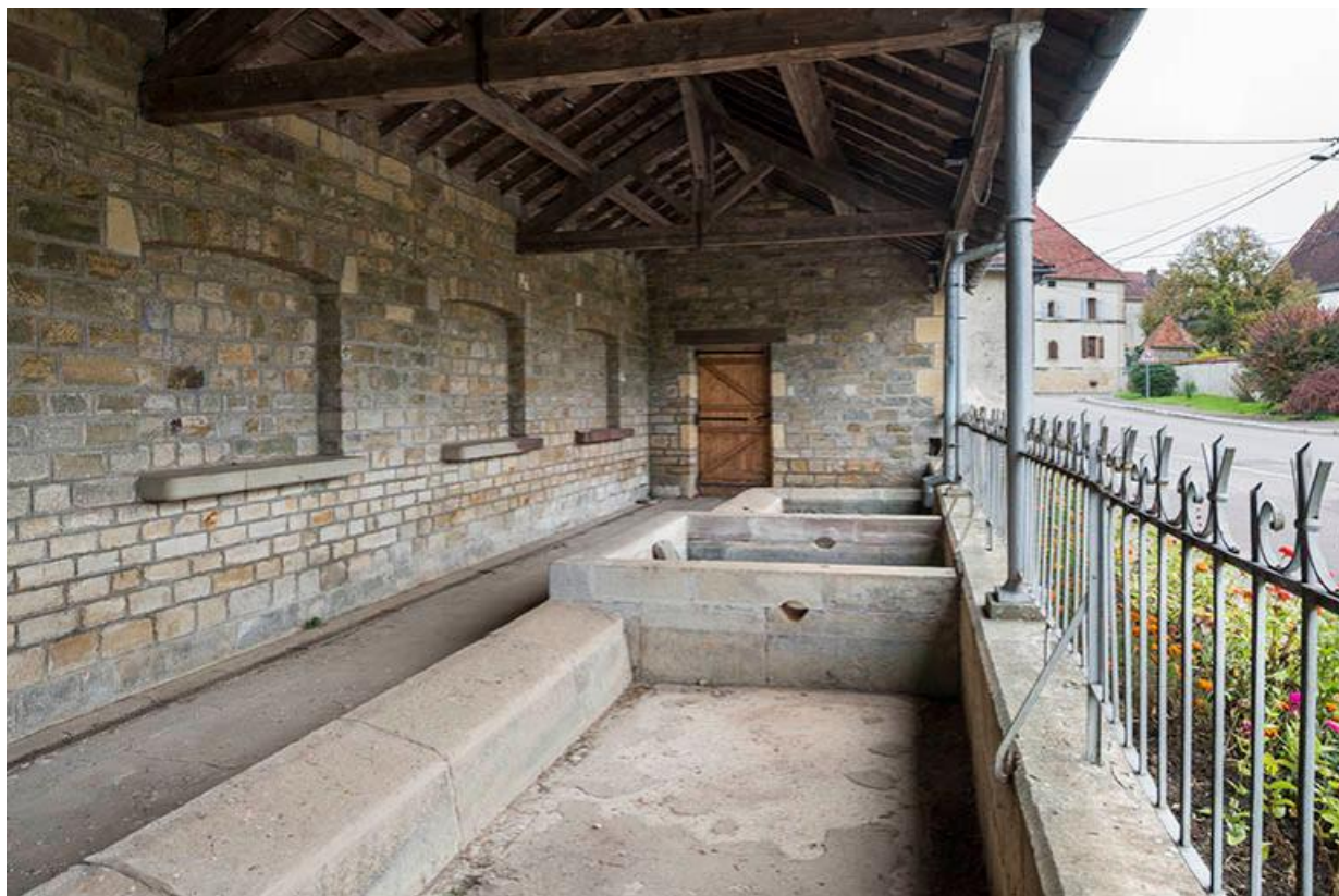
Lavoir communal, les trois bassins couverts, la galerie des laveuses. 70, Baulay
