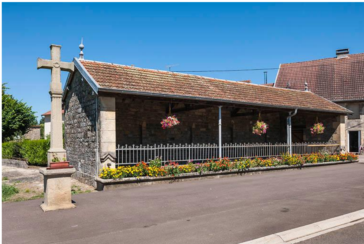
Lavoir communal construit en 1910, calvaire, le long de la route de Fouchécourt. 70, Baulay
