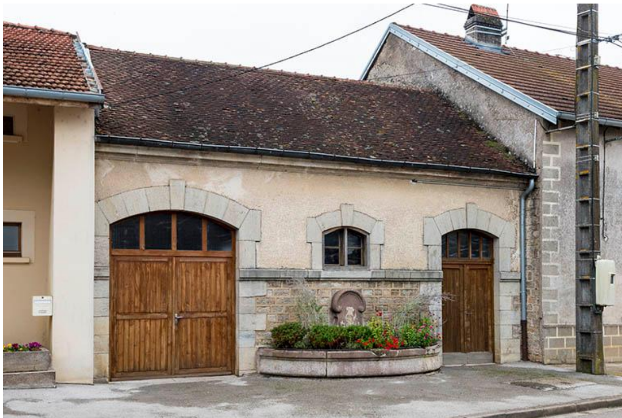
La façade sur rue du lavoir et remise de pompe à incendie, rue des Vignes 70, Baulay
