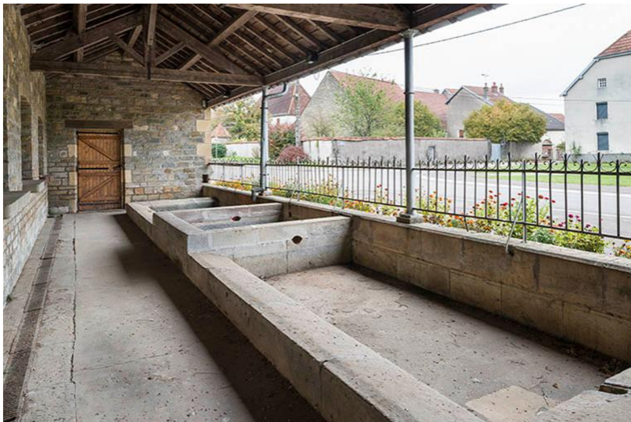
Lavoir communal: les trois bassins et la galerie des laveuses. 70, Baulay
