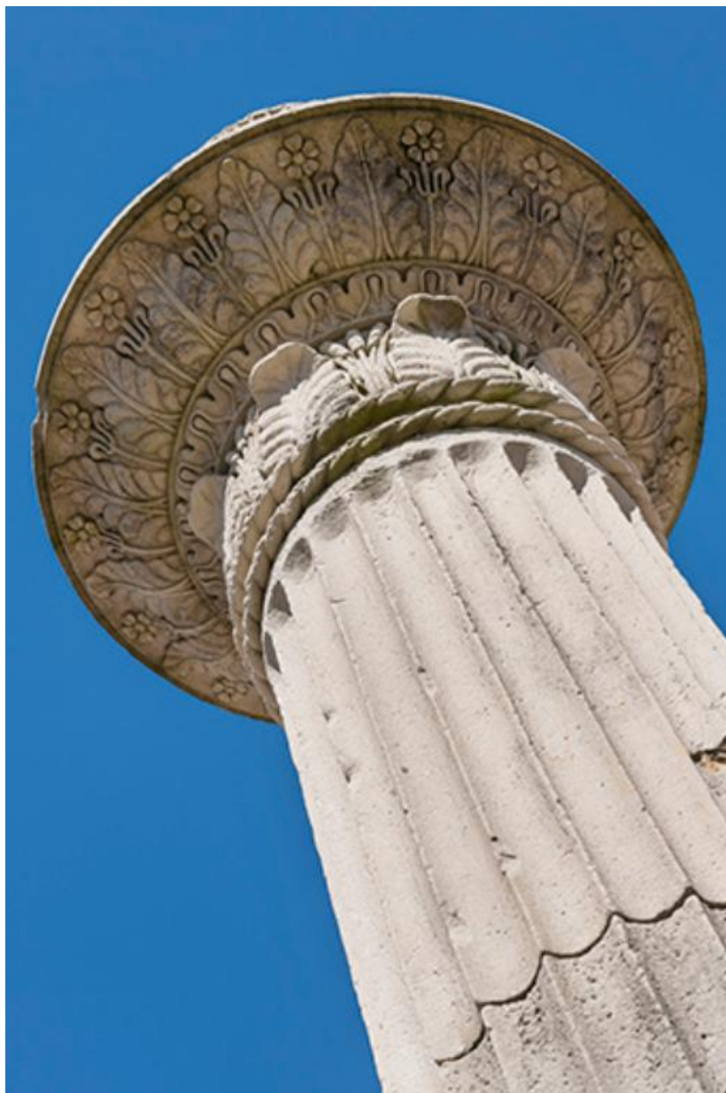
Détail du fut de la colonne et du chapiteau sommital.
