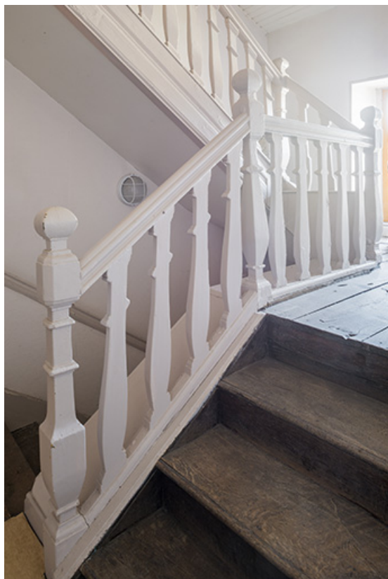
Escalier entre le premier étage et le grenier.
