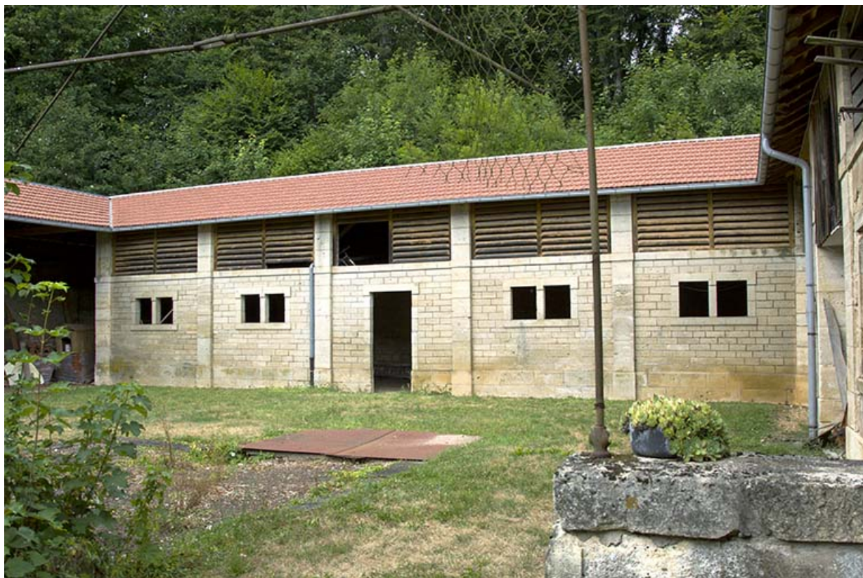
Vue générale de la bergerie, aile nord-ouest.
