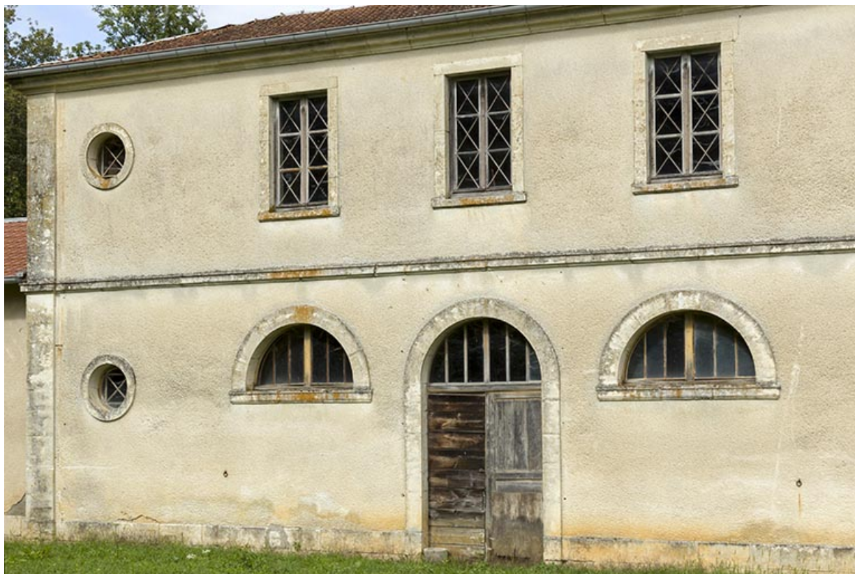
Etable : vue générale de la façade sud-ouest.
