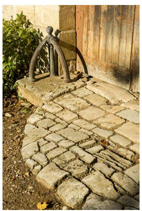
**Travée du corps principal : détail du chasse-roue et du pavage.** 70, Rupt-sur-Saône, 5 rue de la Garenne
