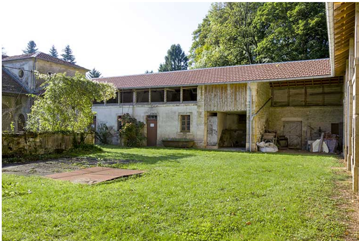
Vue générale de l'aile sud-ouest, côté cour.
