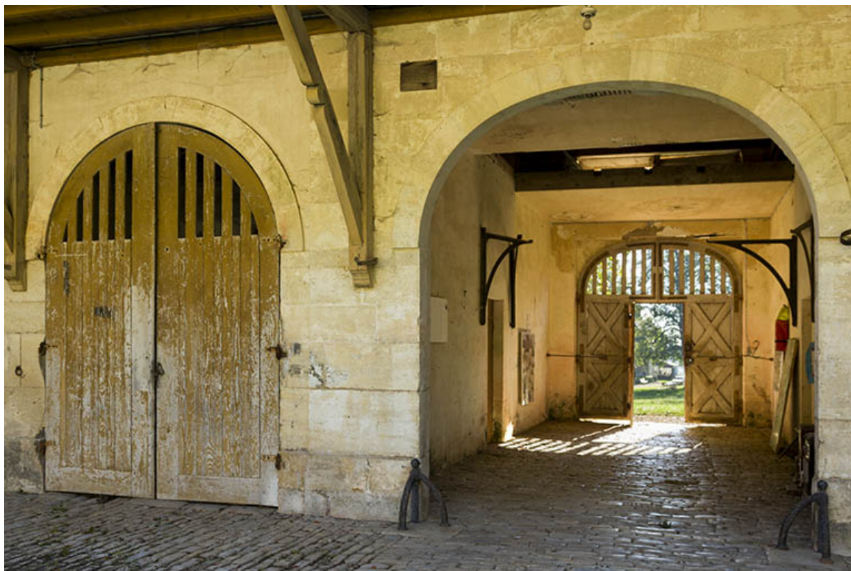
Revers du corps principal depuis la cour : le porche et le passage couvert.
