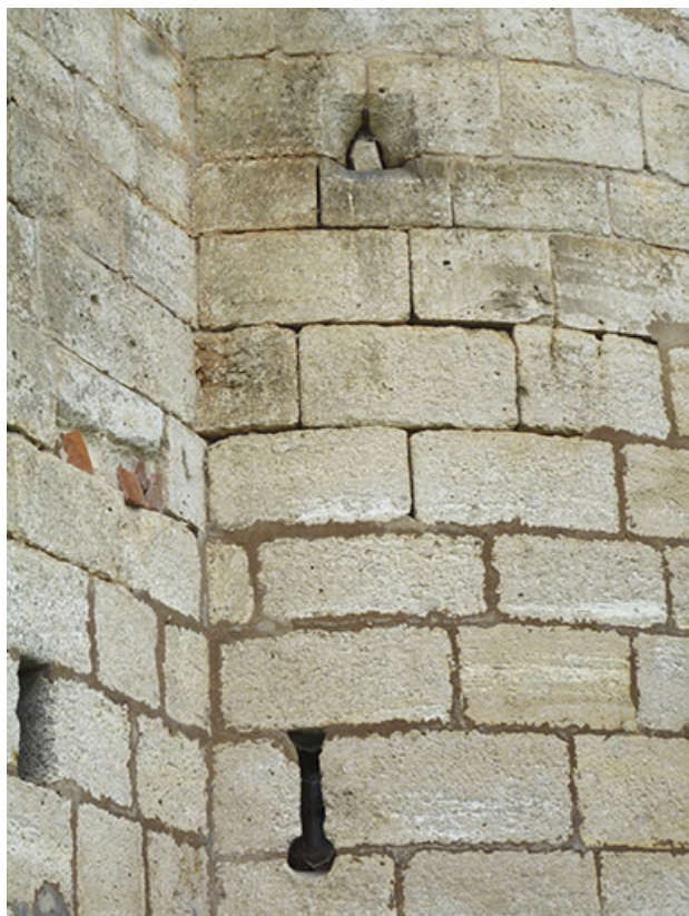
Canonnière du 15e siècle à la base de la tourelle exposée au nord-est. 70, Rupt-sur-Saône, 5 rue de la Garenne
