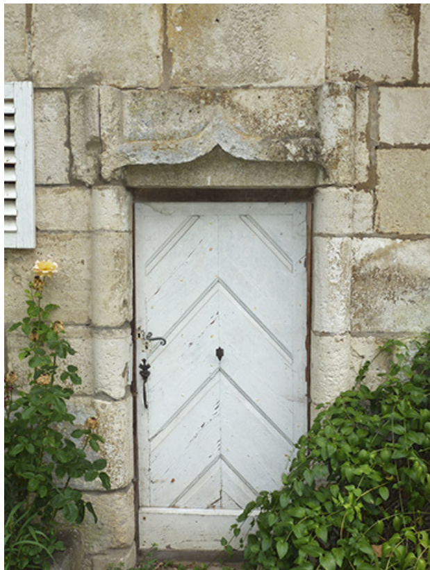
Détail : la porte ouvrant sur l'escalier en vis.
