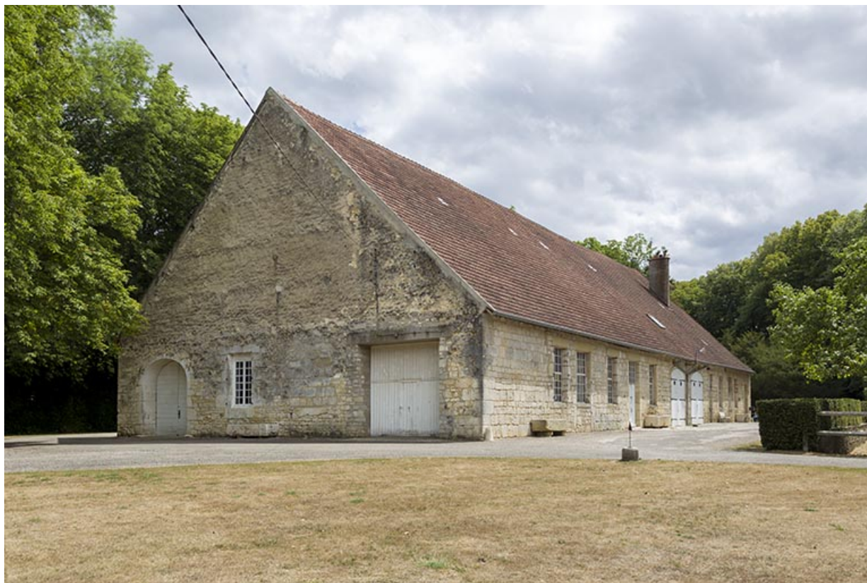
Vue de trois quarts de l'ancien manège.
