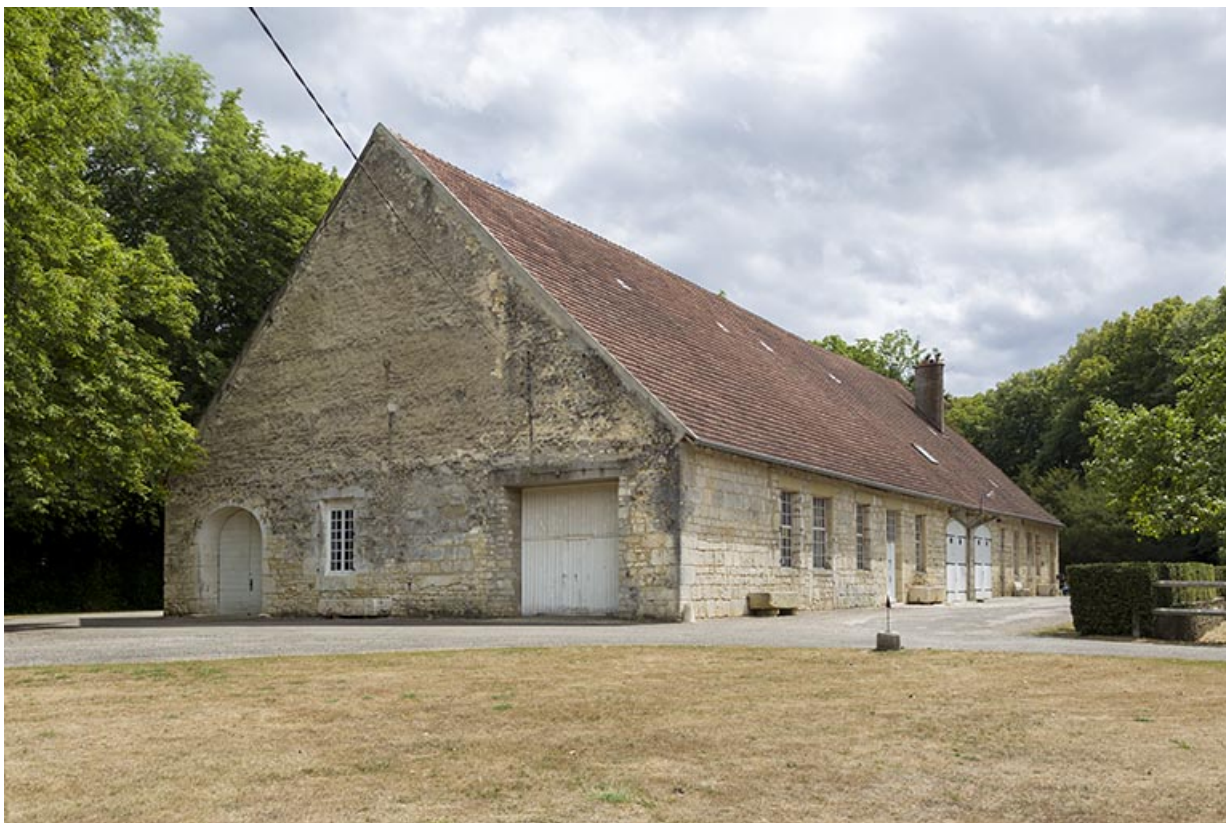
Vue de trois quarts de l'ancien manège.
