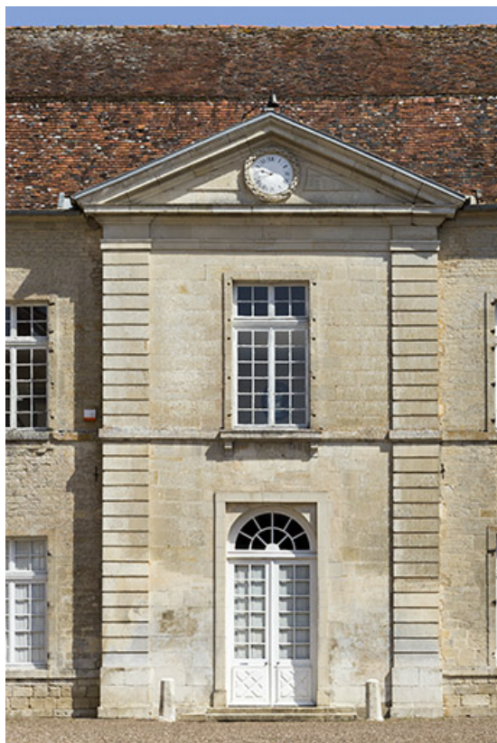
Façade sur la cour d'honneur (façade ouest) : travée centrale. 70, Ray-sur-Saône
