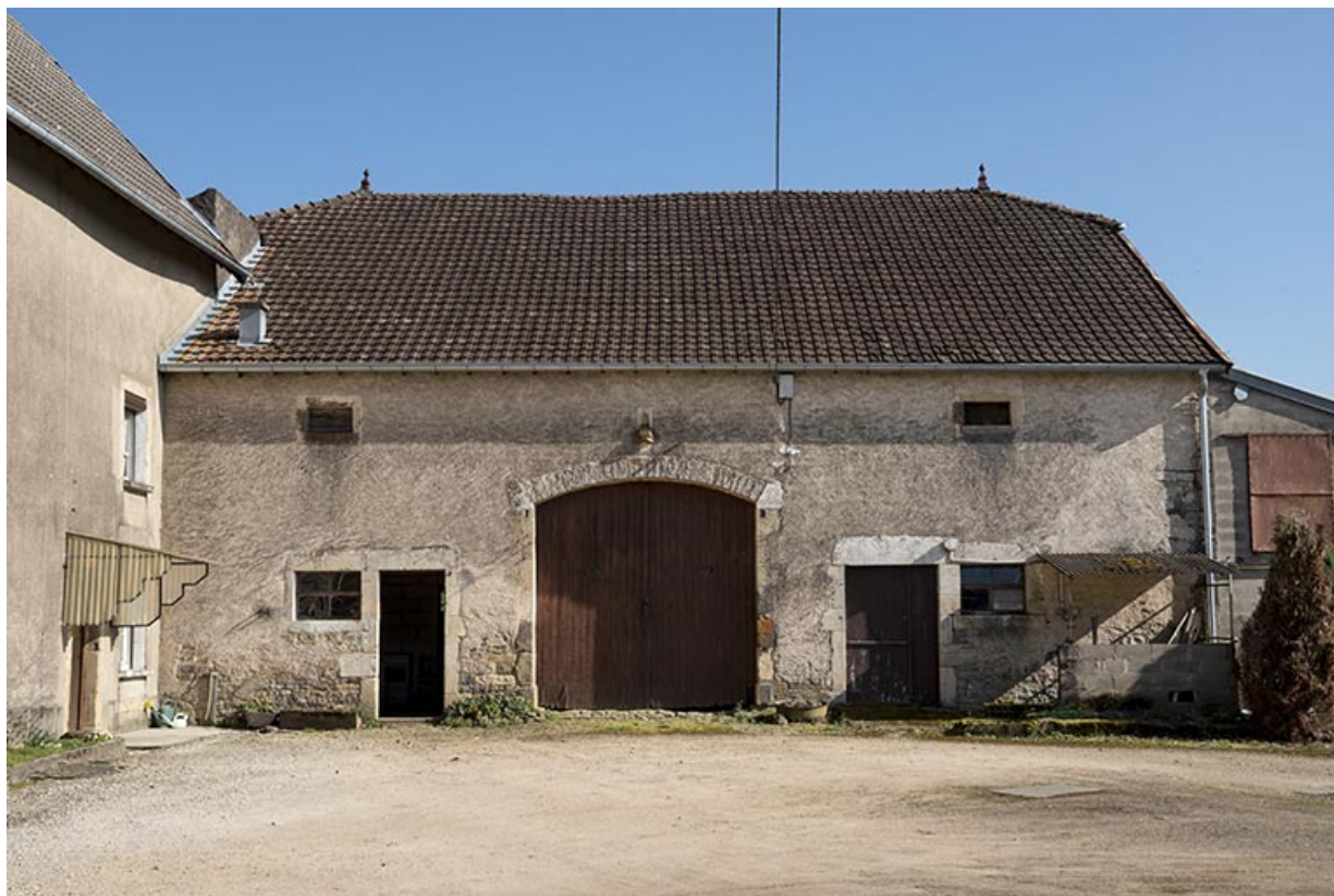
La grange attenante à la ferme.
