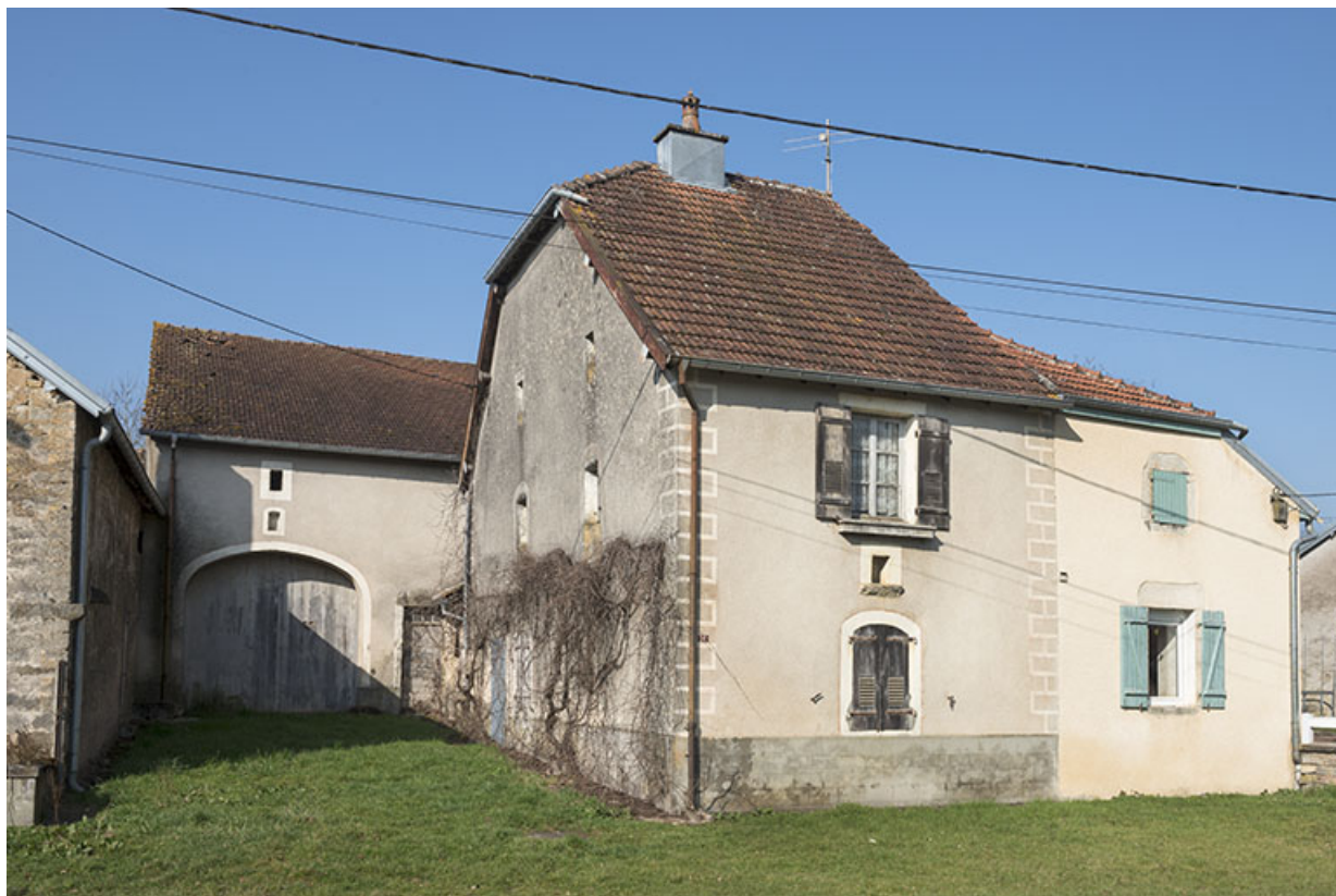
Ferme avec grange en retrait de la rue.
