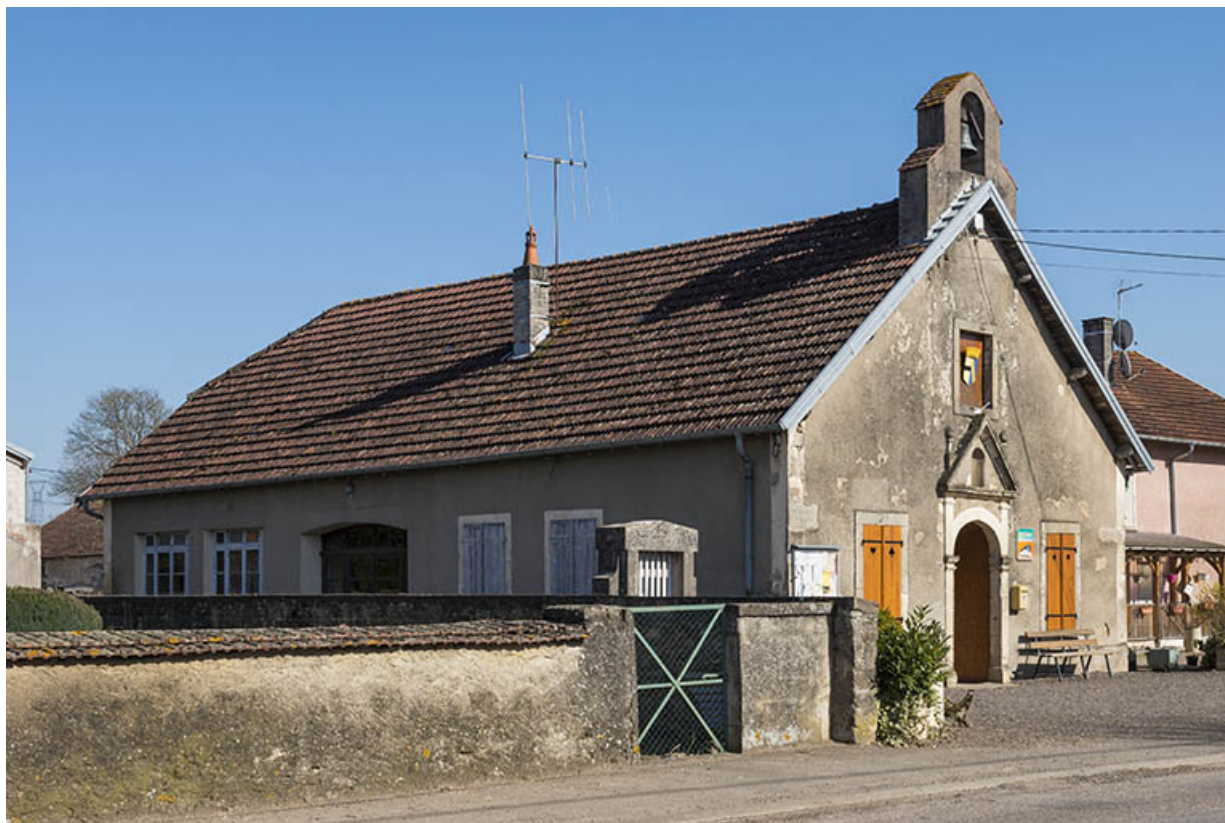
Vue latérale de l'édifice.
