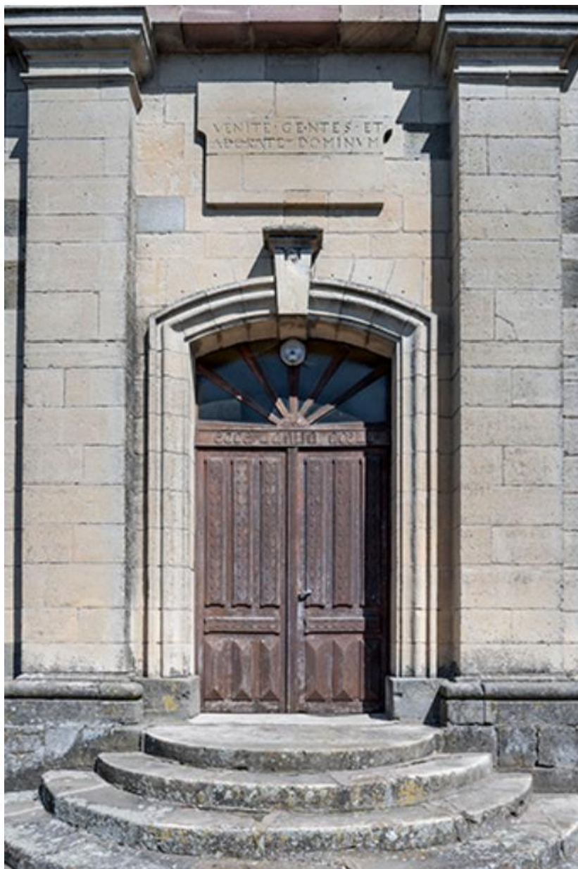
Portail d'entrée de l'église.
