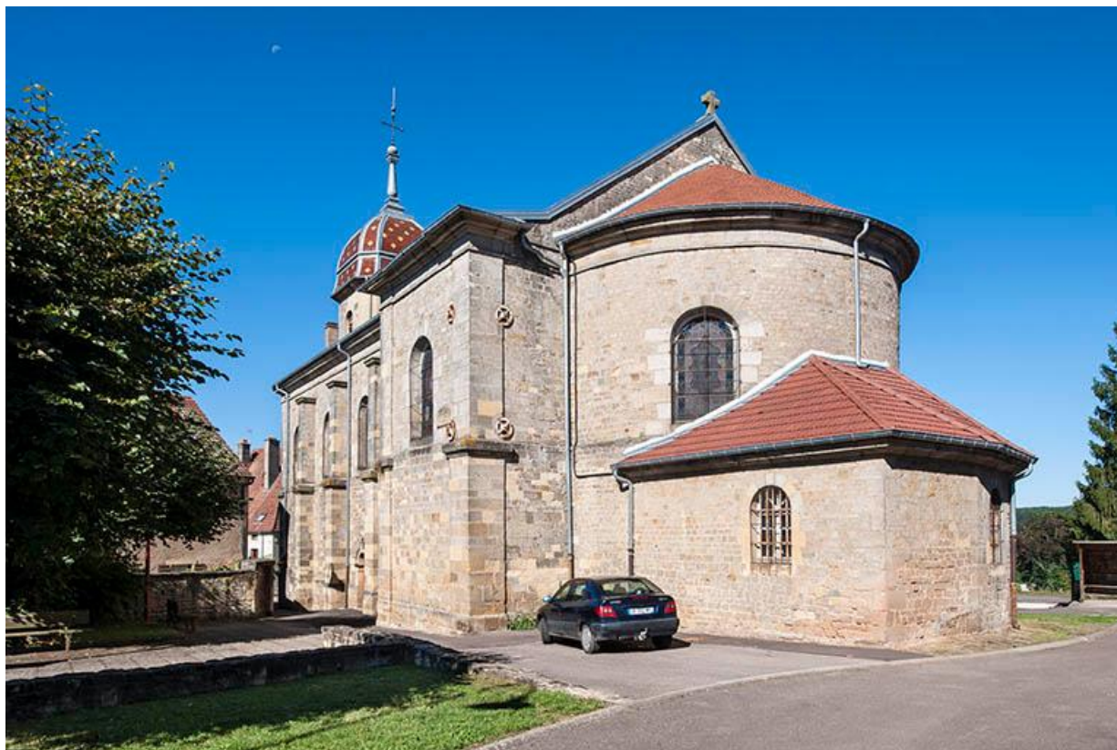
Le chœur et la sacristie de l'église, côté Nord. 70, Baulay rue de l' Église
