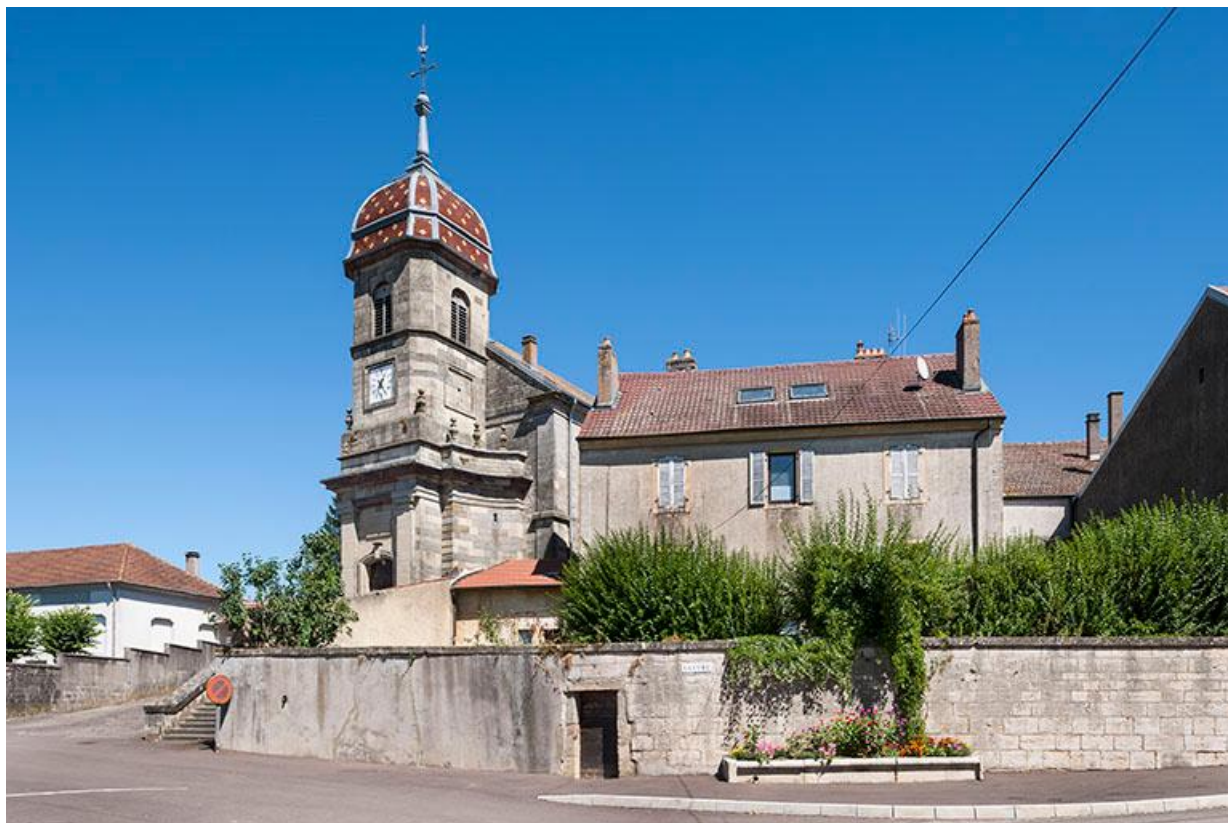
L'église, le presbytère et son jardin et la fontaine de la Cure au premier plan. 70, Baulay rue de l'Église
