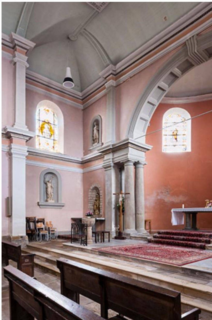
Jonction entre le mur collatéral Ouest et le chœur: retombée de voûte sur deux colonnes doubles. 70, Baulay rue de l'Église
