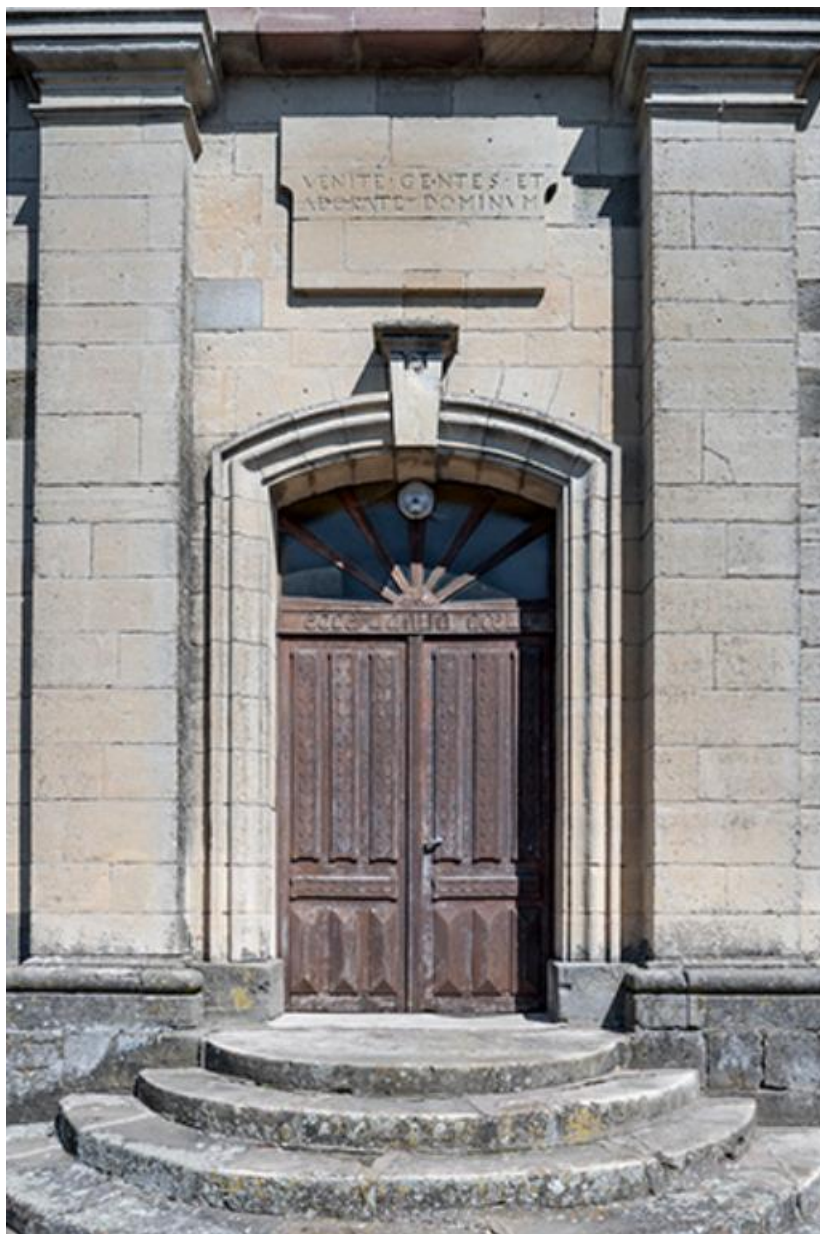
Portail d'entrée de l'église.
